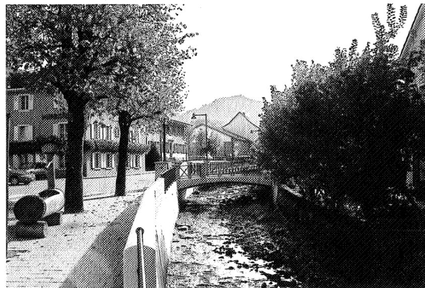
Der Bachlauf ist in das Strassenprojekt integriert. Der Bachquerschnitt ist hochwassersicher geplant worden, seine Ausführung wurde jedoch zurückgestellt. Es sind deshalb nur minimale Anpassungen an den bestehenden Bachlauf vorgenommen worden. Sämtliche erneuerten Kunstbauten, insbesondere Ufermauern und Brücken, tragen aber einem später möglichen Bachausbau Rechnung.
