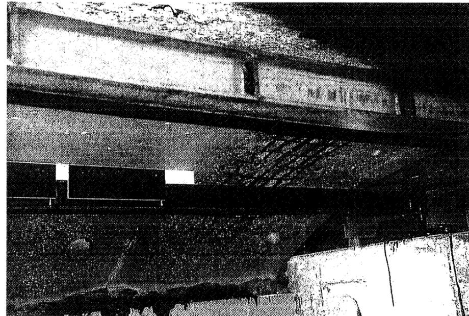
Abb. 19: Grossflächige bis auf die Bewehrung reichende Betonabplatzungen an einem Tübbing [Hosser, D. et al., 1998]
