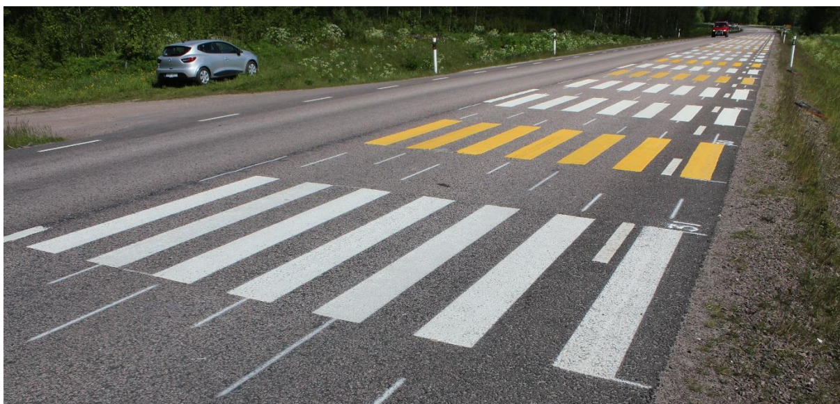
Figur 6. Provfältet där mätningarna gjordes. Markeringarna är utlagda i sju spår där markeringen på vägreken benämns spår 1 och markeringen närmast mittlinjen benämns spår 7. Foto: Mohammad-Reza Yahya, VTI.
