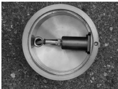
a) Inclinomètre fixé dans son boîtier de retournement
