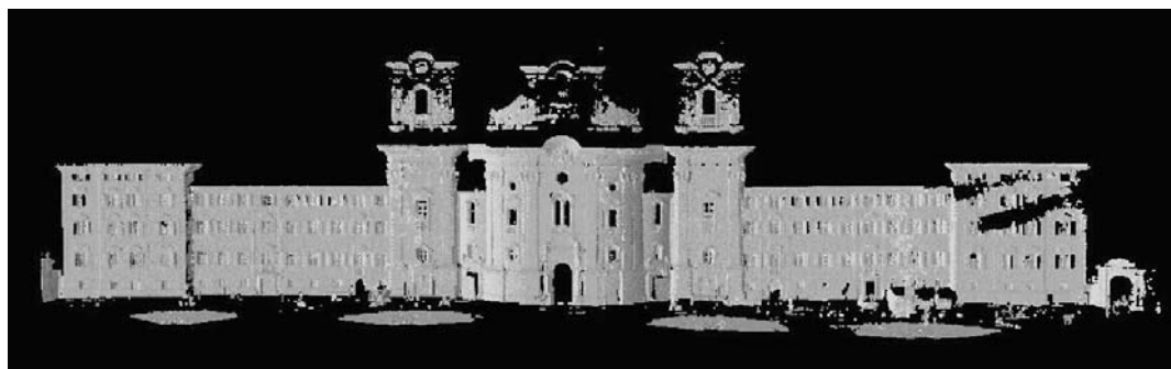
Figure 25: Façade de l'abbaye d'Einsiedeln obtenue par balayage LASER [19]
