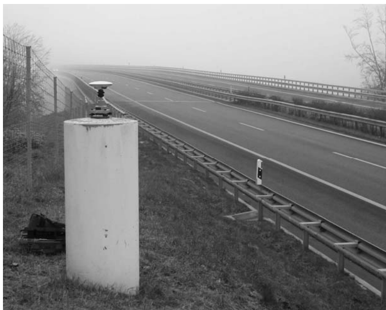
Figure 21: Station GPS permanente au voisinage des ponts sur la Mentue (AI, VD)
