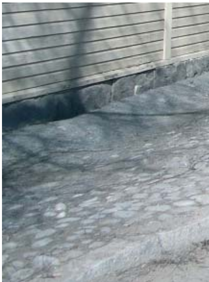
Pintavedet ohjautuvat kivijalan viereen rakennettua kivistä painannetta myöten, Teuro.
