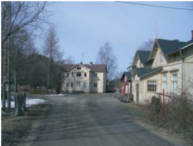
Viihtyisää raittia rajaavat rakennukset, vanhat kivipaadet ja juhannusruusut, Lempäälä.
