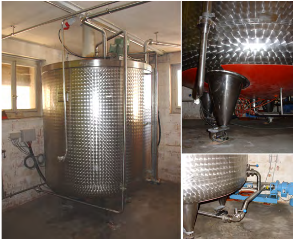
Abbildung 20: Der Rohöltank mit den Rohranschlüssen (links), den zwei Ausläufen zur Schneckenpumpe (rechts unten), den Kraftmessdosen zur Gewichtserfassung und der Heizmatte zur Temperierung des Rapsöles (rechts oben).
