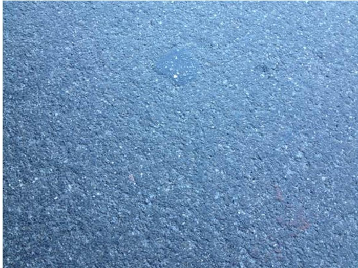
Abbildung 23 Belagsoberfläche auf der Teststrecke in Visp
