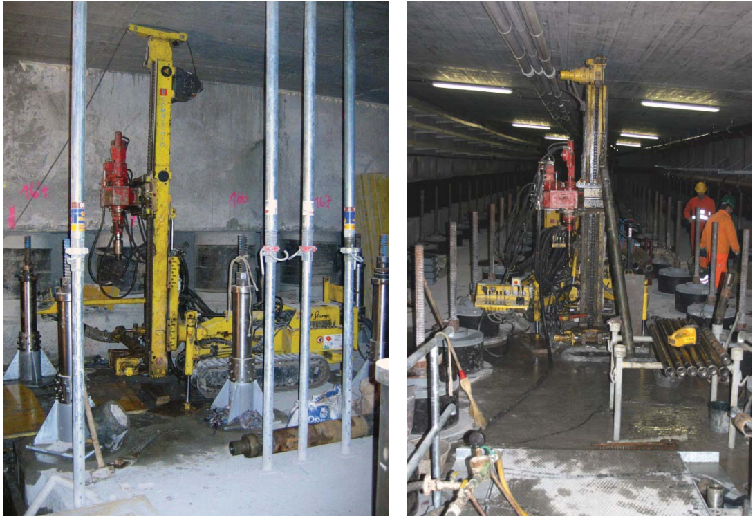
Abb. 4.5 Bohrgerät beim Abteufen der Kernbohrungen (links Bohrung TM 935 und rechts Bohrung TM 2040)
