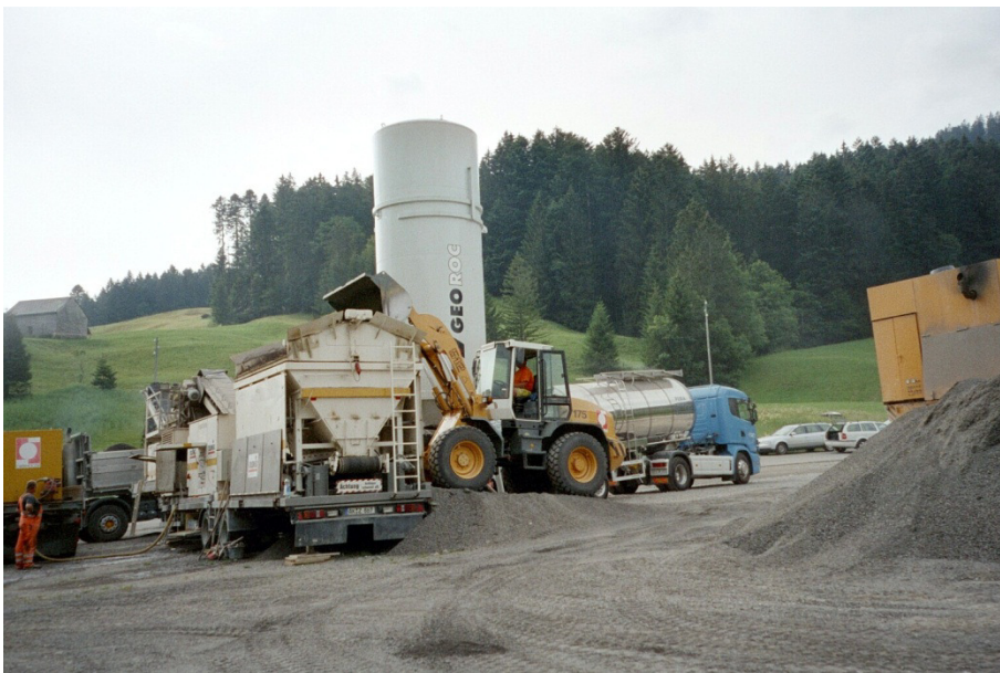
Abbildung 2: Mobile Kaltrecycling-Mischanlage, Wirtgen KMA 220.
