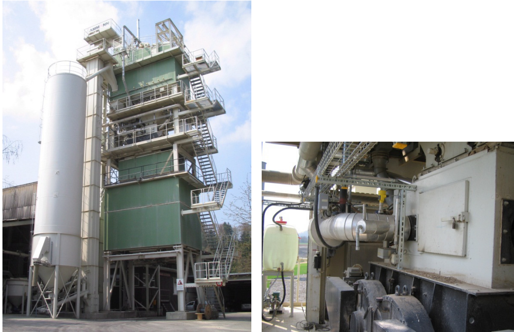
Abbildung 3: Stationäre Anlage mit Schaumbitumeneinheit (Belags AG Böttstein).
