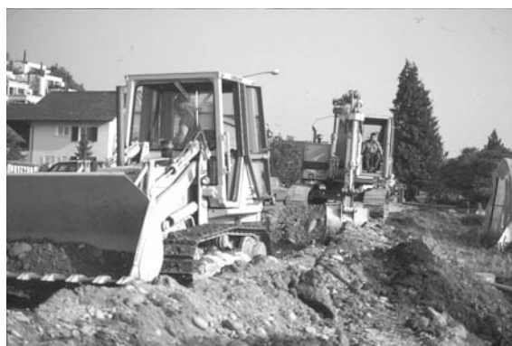
Bild A1.8: Aushub längs der Kantonsstrasse beim Sickerschacht
