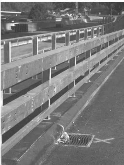
Bild 14: Leitschranke System 66, LS 2x 150'180 - 50'100 1,33 m mit Aufhaltstufe H2 gemäss [12]
