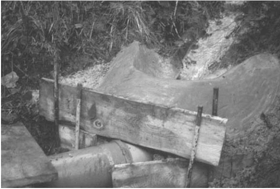
Bild A6.9: Notfassung am unterem Ende der Abflussrinne zur Lorze
