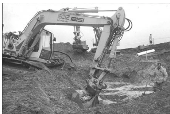
Bild A6.7: Aushubarbeiten über dem Sickerwasserspiegel
