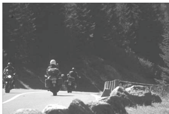
Bild 11: Gefährliche Felsblöcke am Rand einer Ausserortsstrasse
