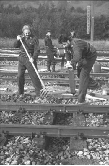
Bild A3.9: Verlegen von Schlauchleitungen unter den Geleisen
