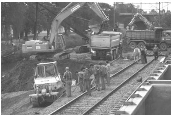
Bild A2.6: Aushub von kontaminiertem Boden
