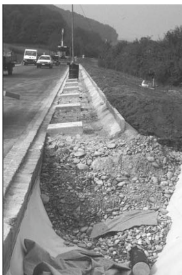
Bild 16: Bankettabdichtung mit Kunststoff-Dichtungsbahnen
