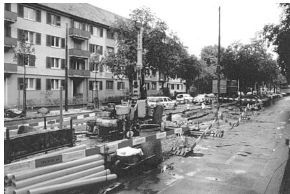
Bild A5.4: Bohrarbeiten zur Messung von Bodenluftpegeln
