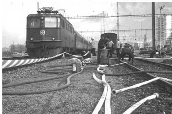
Bild A3.8: Beginn der Sanierung neben dem Bahnverkehr
