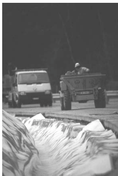
Bild 15: Böschungsabdichtung mit Kunststoff-Dichtungsbahnen
