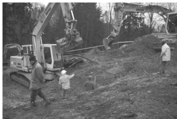
Bild A6.6: Aushubarbeiten unterhalb des Einsickerbereichs
