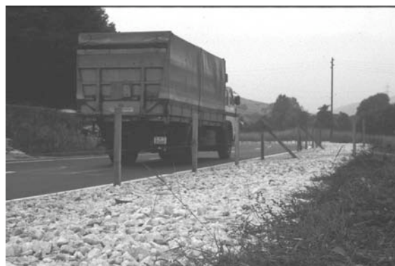
Bild 13: Hindernisfreier Seitenraum an einer Hauptverkehrsstrasse (Grundwasserschutzzone)
