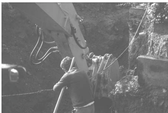
Bild A1.7: Freigelegte Leitungen
