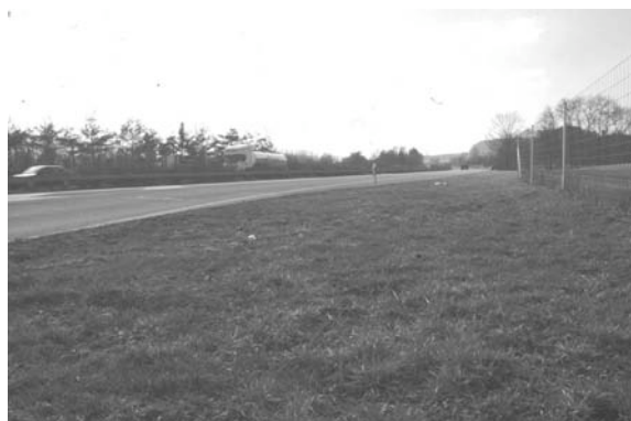
Bild 12: Hindernisfreier Seitenraum an einer Autobahn
