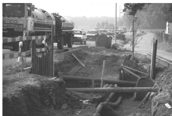
Bild A1.4: Freigelegte Leitungen in der Umgebung des Sickerschachtes
