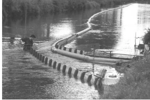
Bild A2.3: Doppelte Ölsperre (vier Tage nach dem Ereignis)
