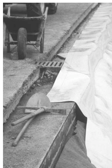
Bild 17: Anschluss einer Dichtungsbahn an den Belagsrand
