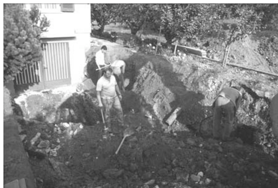
Bild A1.6: Aushub bei einer Garagenabfahrt
