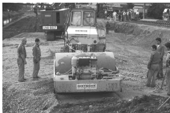
Bild A2.9: Verdichten des Schüttmaterials
