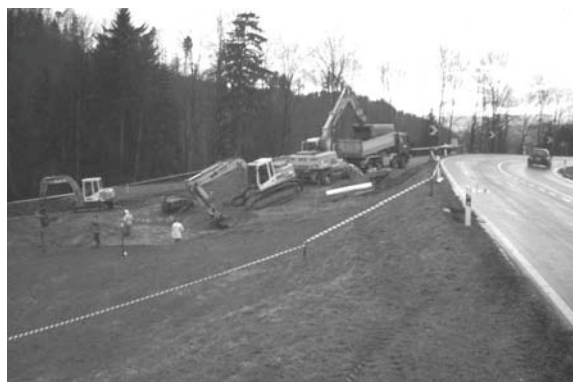
Bild A6.5: Übersicht über die Sanierungsarbeiten im Einsickerbereich
