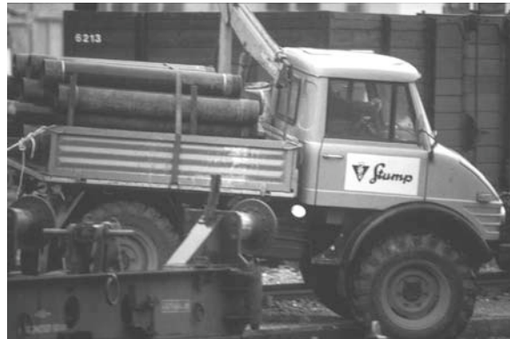
Bild A3.4: Anfahrt der Bohrequipe
