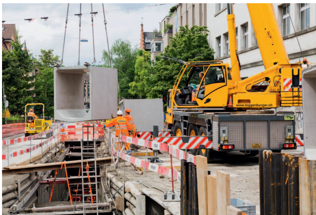
6 | Insgesamt 133 Beton-elemente wurden mit dem Kran in den Graben gesenkt (Foto: Stefan Kubli). 6 | Au total, 133 éléments en béton ont été mis en place dans la tranchée à l'aide d'une grue (photo: Stefan Kubli).
