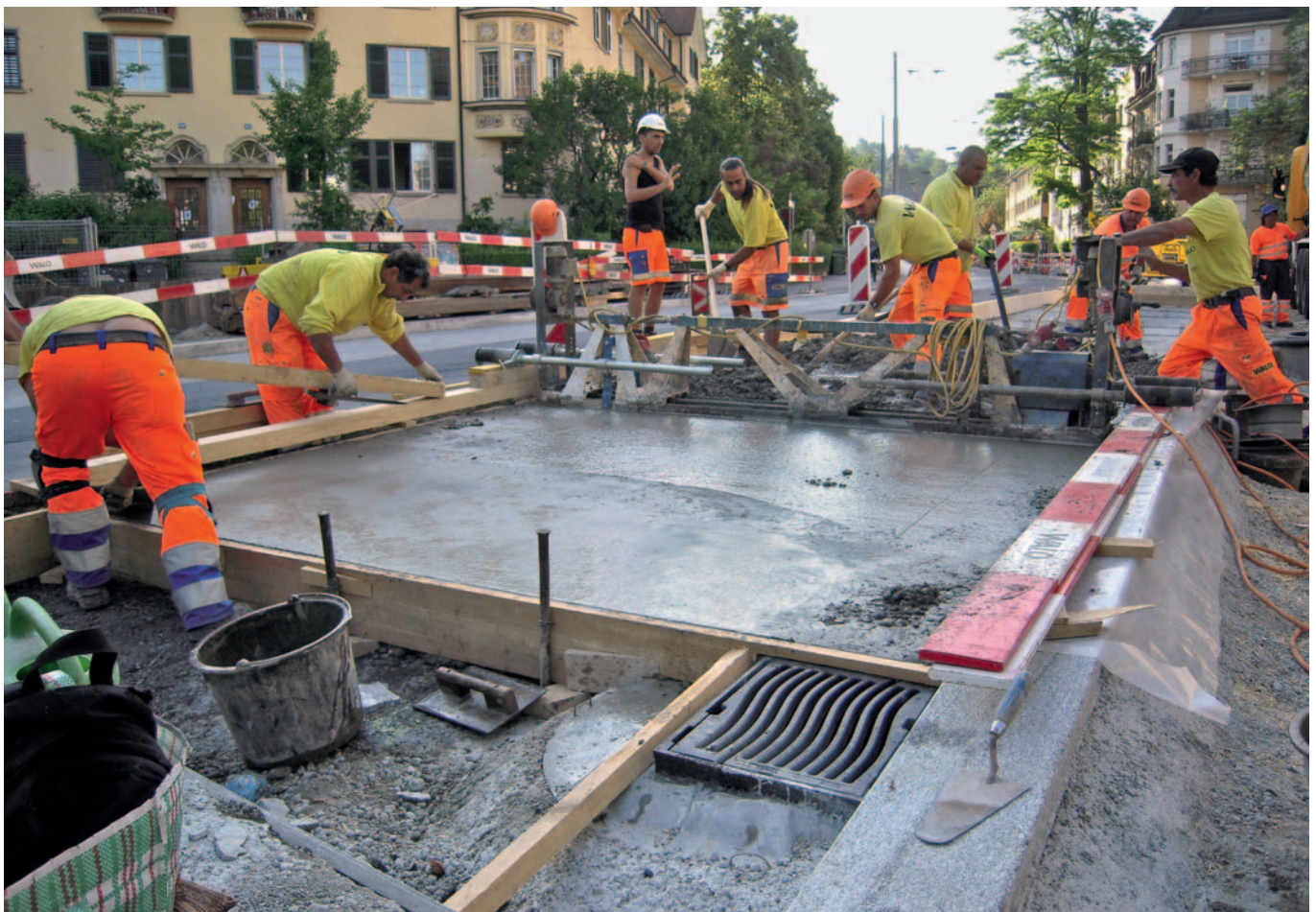
8 | Einbau der Busplatte bei der neuen Kaphaltestelle Scheuchzerstrasse (Foto: Moritz Wildi).
