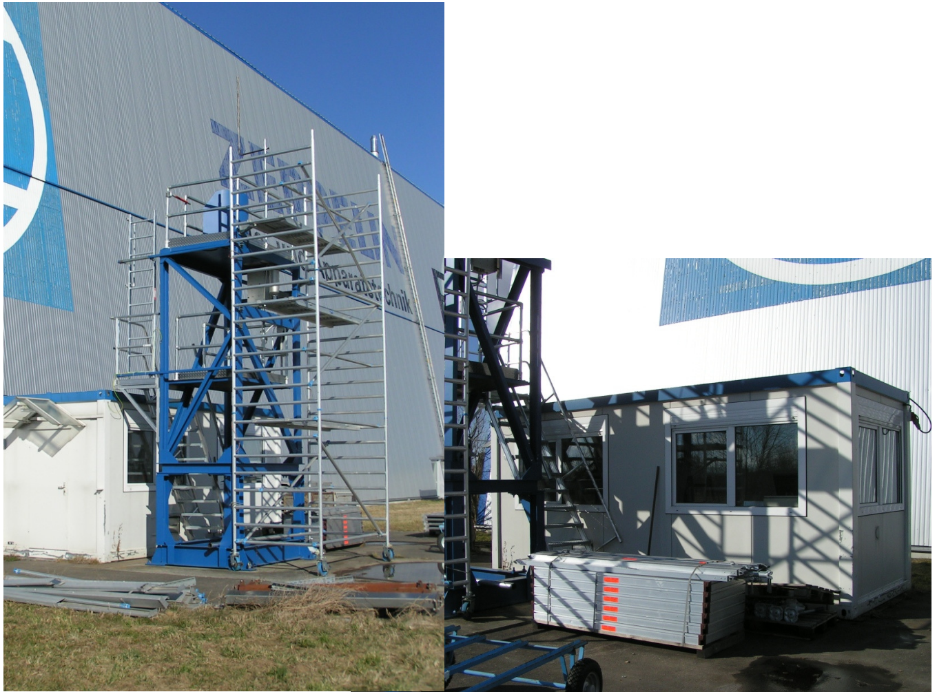
Bild 7 ZLT Triebwerksprüfstand während des Aufbaues
