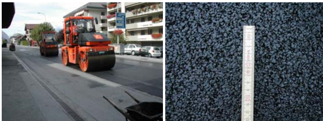
Abbildung 14 Bei feinkörnigem Mischgut sind hohe Anforderungen an die Gesteinskörnung 2/4 zu stellen. Die Fotos zeigen den Einbau und die Oberflächenstruktur eines AC MR4, EOS.
