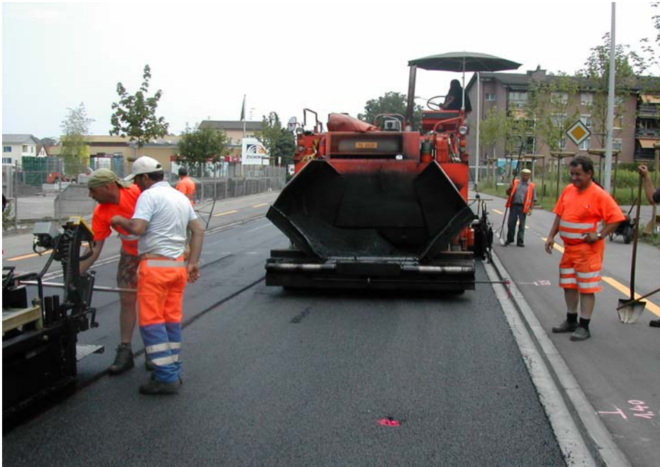
Abbildung 8 Einbau des 2-schichtigen offenporigen Asphalttes (Twinlayer). Als untere Schicht wurde ein PA 8 eingebaut, als obere Schicht ein PA 4.
