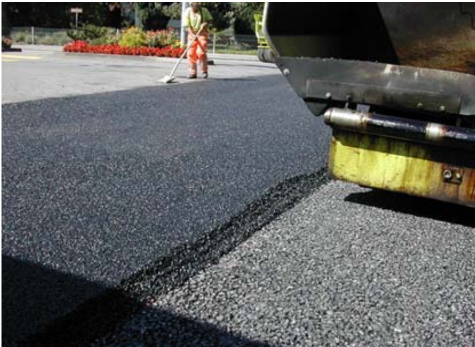
Abbildung 9 Einbau heiss auf warm des PA8 auf PA16 als Twinlayer
