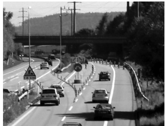
Abb. 5-16: Verschwenkung des Normalfahrstreifens nach der Mittelstreifenüberfahrt
