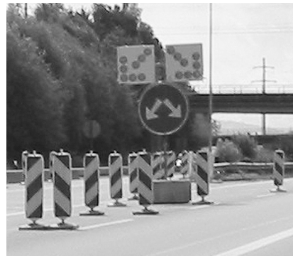
Abb. 2-5: Blinkende Abweispfeile in Hochlage zu Beginn einer Überleitung
