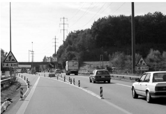
Abb. 2-6: Niedrige Leitbaken aufgesetzt auf Leitschiene in einstreifiger Mittelstreifenüberfahrt
