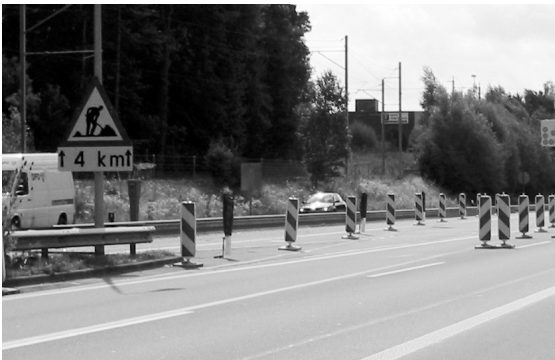
Abb. 2-4: Leitbaken im Grossformat in einstreifiger Mittelstreifenüberfahrt
