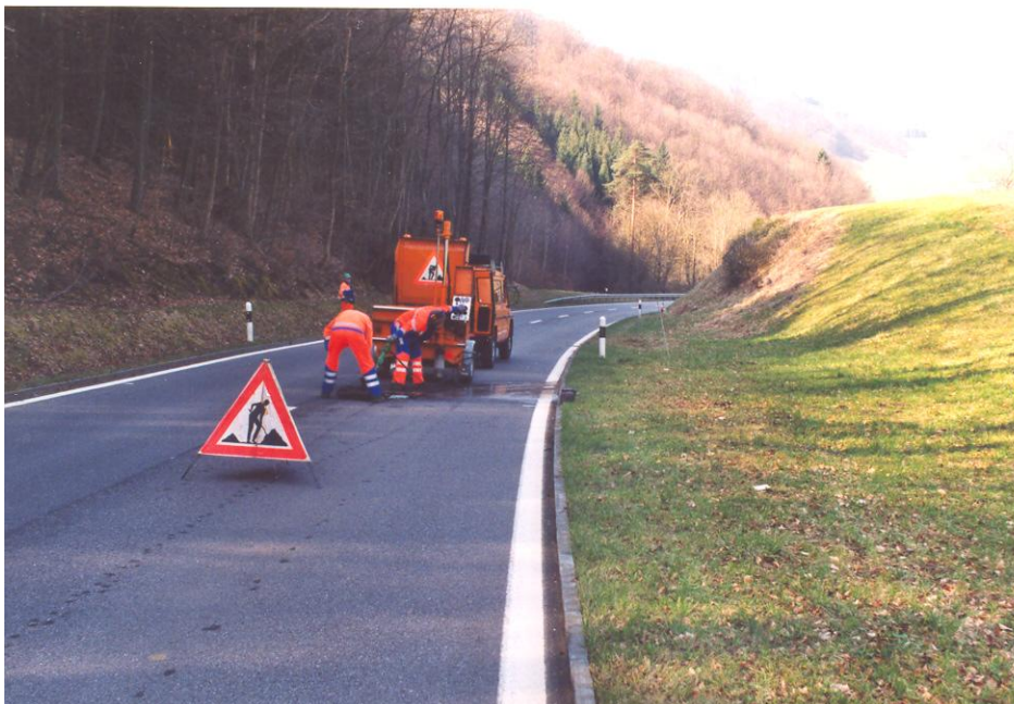
Abbildung 7: Kantonsstrasse nach Gansingen im Kanton AG1
