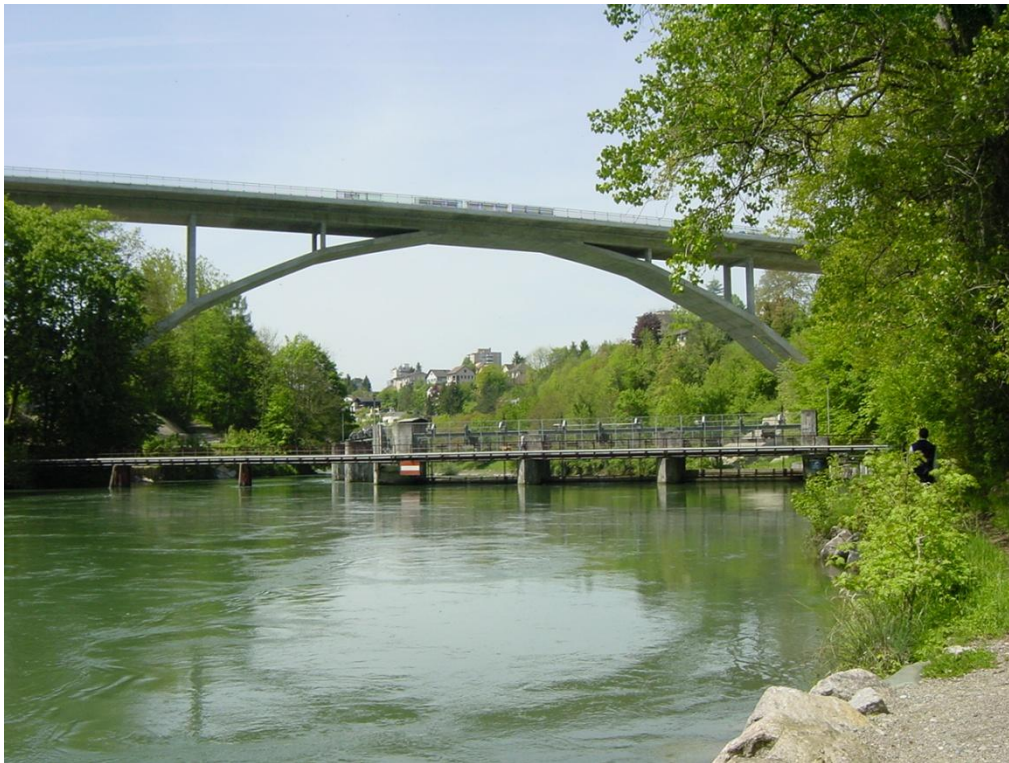
Abbildung 12: Objekt AG2: Brücke über die Limmat bei Obersiggenthal
