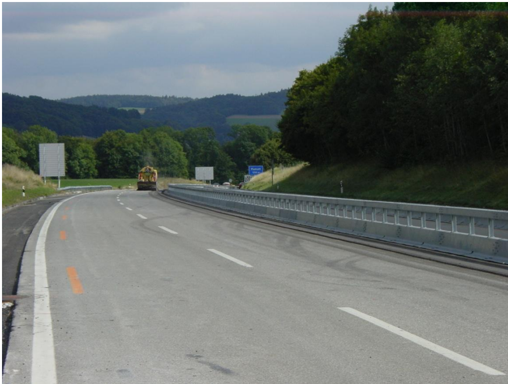
Abbildung 16 Objekt FR1; Blick Richtung Bern
