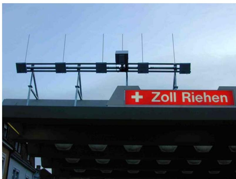
**Abbildung A - 3 DSRC-Bakenanlage auf dem Dach eines Zollamts**
