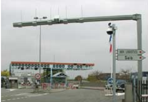
Abb. 5.6 Baken zur Informationsübermittlung gemäss Peugeot [76]
