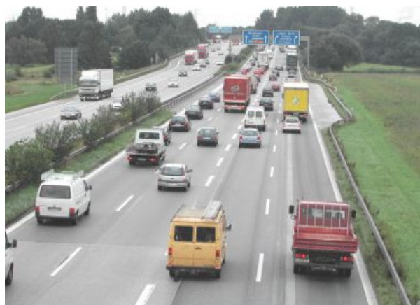
Abb. 5: Permanente Umwidmung des Standstreifens auf der A1 in Fahrtrichtung Norden zwischen AS HH-Stillhorn und AK HH-Süd
