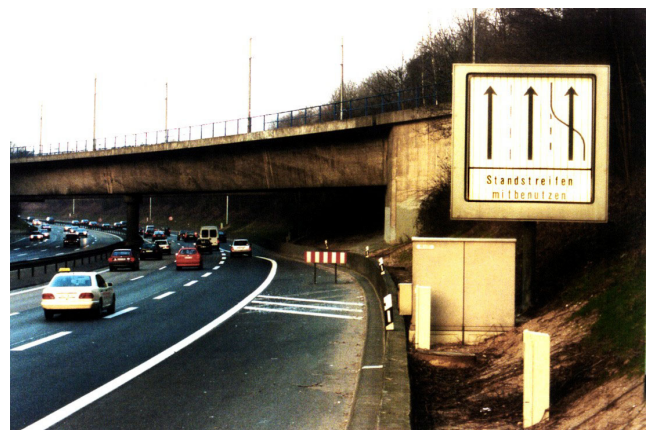
Abb. 7: Temporäre (festzeitgesteuerte) Umwidmung des Standstreifens auf der A4 in Fahrtrichtung Köln zwischen AS Refrath und AS Köln-Merheim
