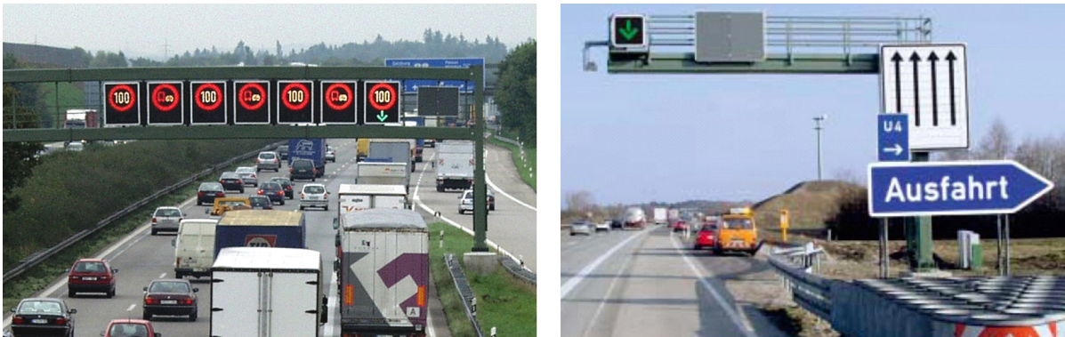
Abb. 14: Anzeigen zur temporären Benutzung des Standstreifens auf der A99 im Querschnitt der Streckenbeeinflussungsanlage (links) und mit FLS und Prismenwender im Bereich einer Anschlussstelle (rechts) [17]
