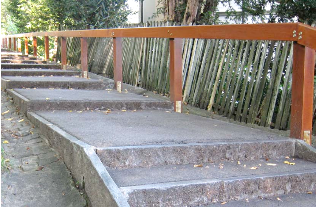
Abbildung 31 Treppenhandlauf aus Holz
