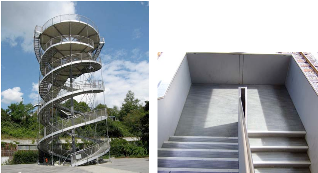
Abbildung 4 Beispiel einer Wendeltreppe und einer zweiläufig gewendeten Treppe mit Halbpodest
