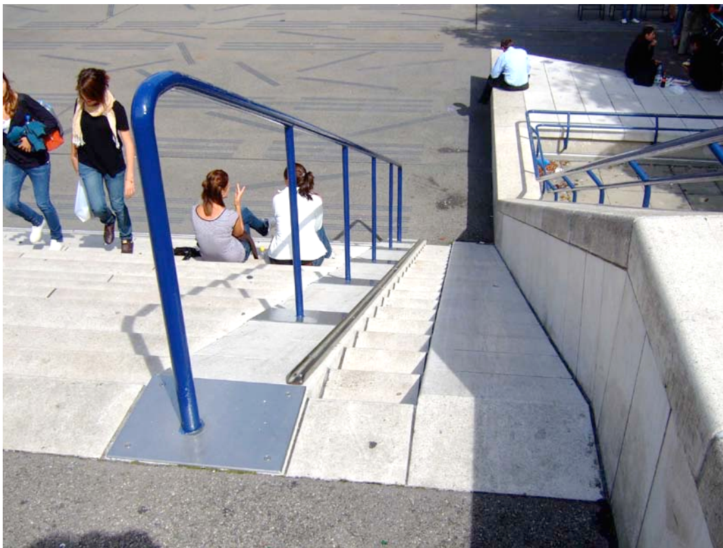
Abbildung 35 Anordnung eines Handlaufs zwischen Treppe und Kinderwagenrampe
