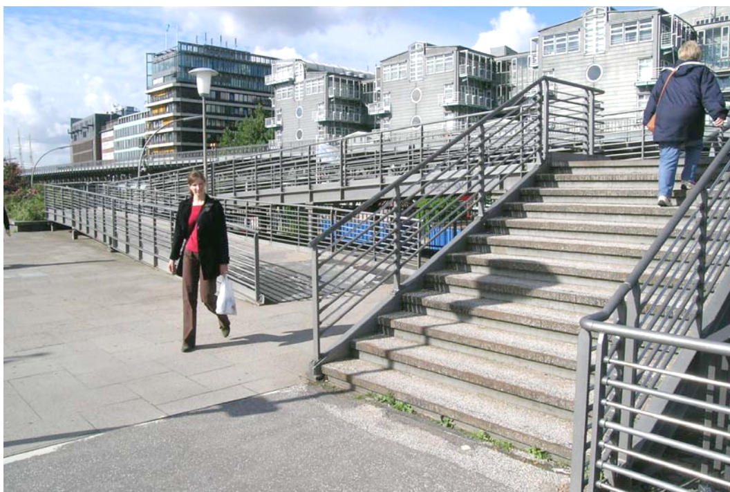
Abbildung 11 Gewendete Rampe mit Treppe kombiniert (Hamburg)
