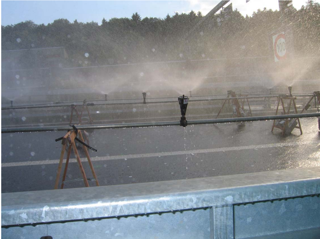
Abbildung 2: Beregnungsversuch Standort Birmensdorf
