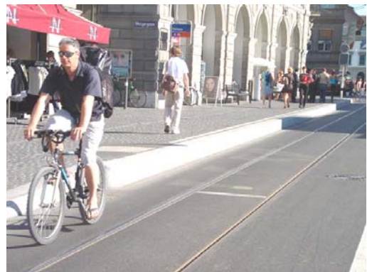
Durchgehende Perronkante mit 30cm (Beispiel: Haltestelle Rathaus, Limmatquai Zürich)
