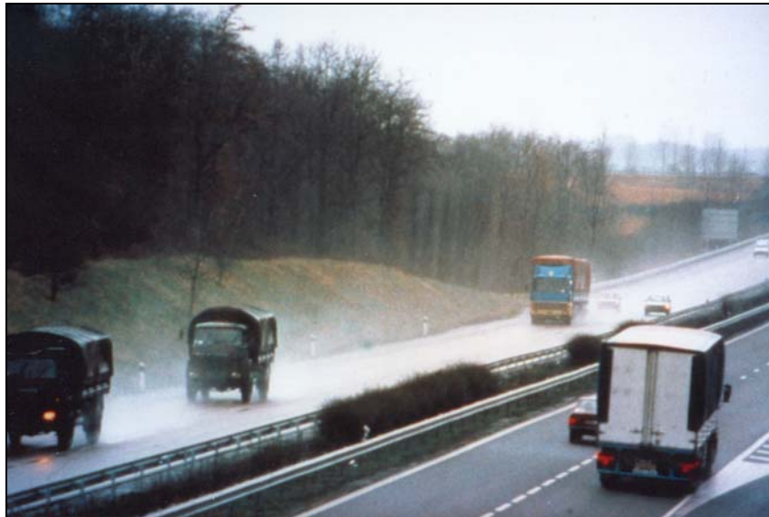
Abbildung 1: Reduktion der Sprühhahnenbildung bei der offenporigen im Vergleich zur dichten Asphaltdeckschichtbauweise (Quelle: Deutscher Asphaltverband e.V.)
