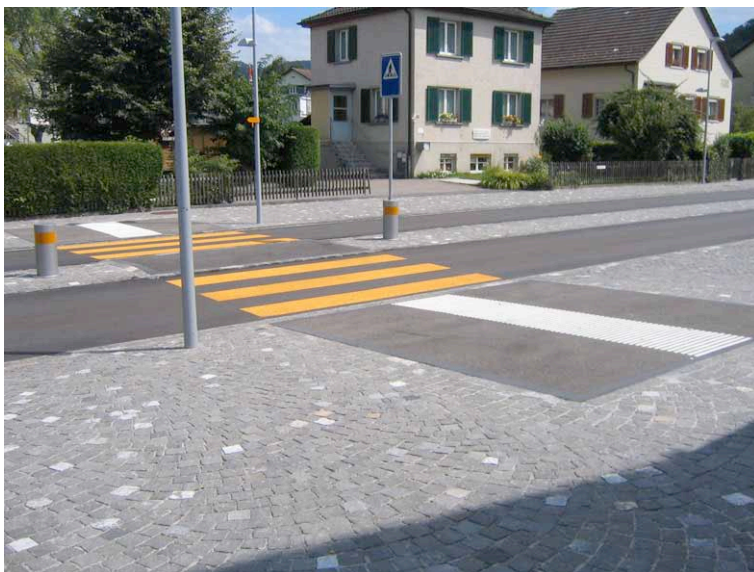
Abbildung 22 Schutzinsel im Bereich eines Mehrzweckstreifens, Birmensdorf: Die Position des Fussgängerstreifens ist mit taktil-visuellen Aufmerksamkeitsfeldern markiert
