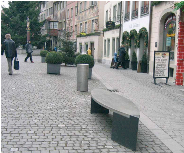
Abbildung 41 Befahrbarer Pflasterstreifen in einem Fussgängerbereich
