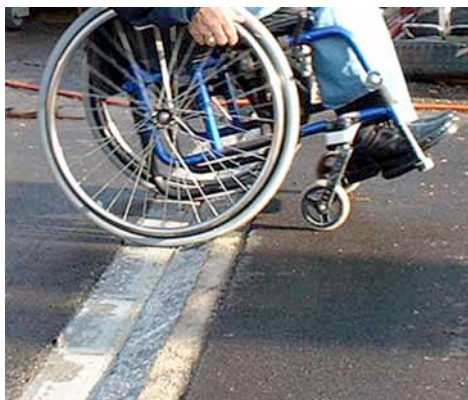
Abbildung 12 Kurze angerampte Randabschlüsse von max. 4 cm Höhe sind mit dem Rollstuhl überfahrbar.
