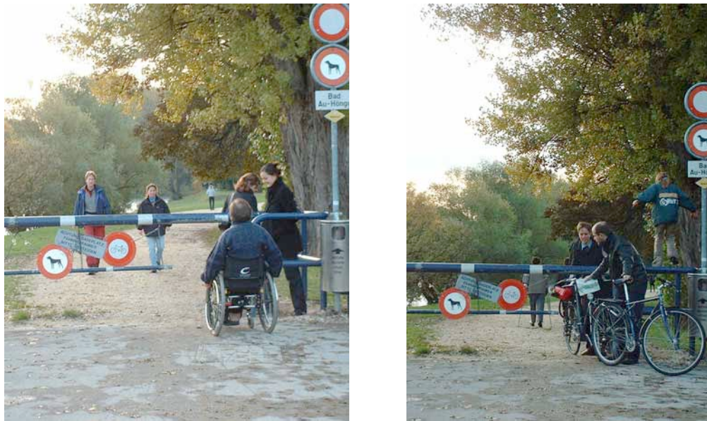
Abbildung 2 Zürich, Limmatweg: Schranken, die den Zugang für Velos verhindern sollen, stellen für Rollstuhlfahrende unüberwindbare Hindernisse dar
