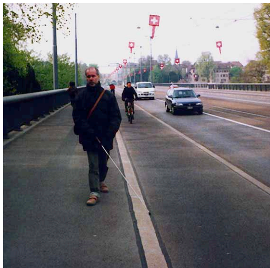
Abbildung 20 Wettsteinbrücke, Basel: Trennung von Rad und Gehweg mit einer Niveaudifferenz und einem schrägen Randstein
