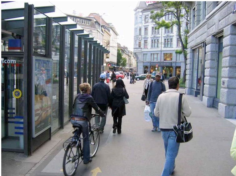
Abbildung 35 Radführung hinter einer Bushaltestelle
