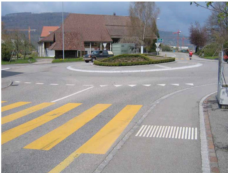
Abbildung 30 Fussgängerstreifen an einem Kreisel: Markierung mit einem taktil-visuellen Aufmerksamkeitsfeld
