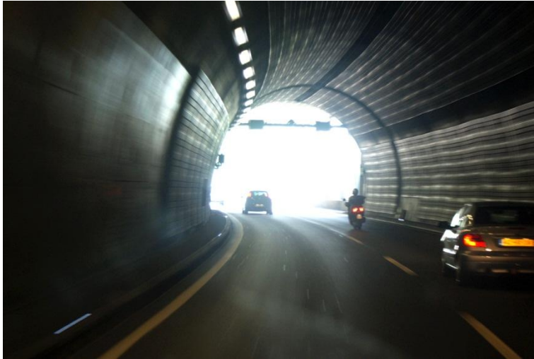
Abb. XI.35 Ausfahrstrecke mit Tunnelwand- und Deckenverkleidung
