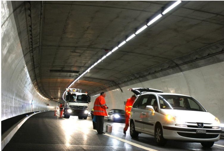
Abb. XI.26 Ermittlung der Reflexion der Fahrbahn, Westumfahrung Zürich
