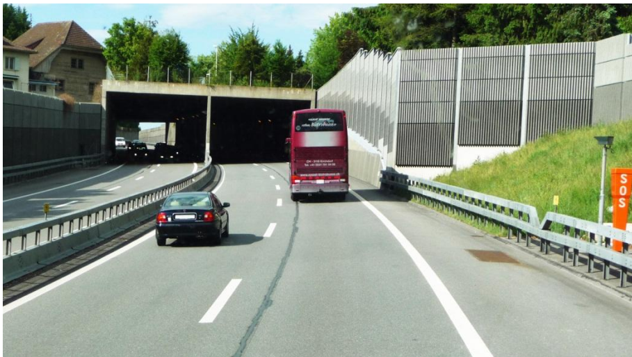
Abb. V.9 Beispiel einer Annäherungsstrecke mit einer Portalumgebung mit Schallschutzwänden, Bepflanzung, Bepflanzung und Himmel
