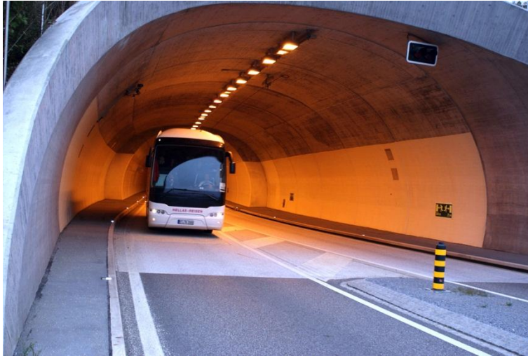
Abb. XI.38 Helle Fahrbahn, Olten Aarburg
