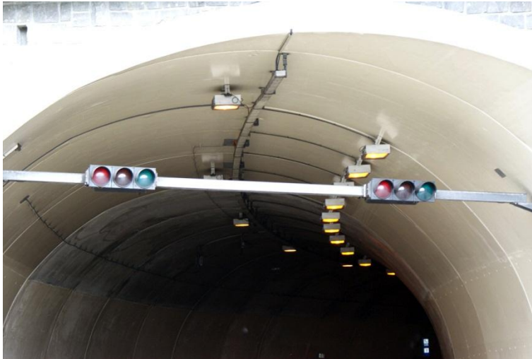
Abb. XI.39 Punktbeleuchtung im Tunnel mit Gegenverkehr, Brünigpass
