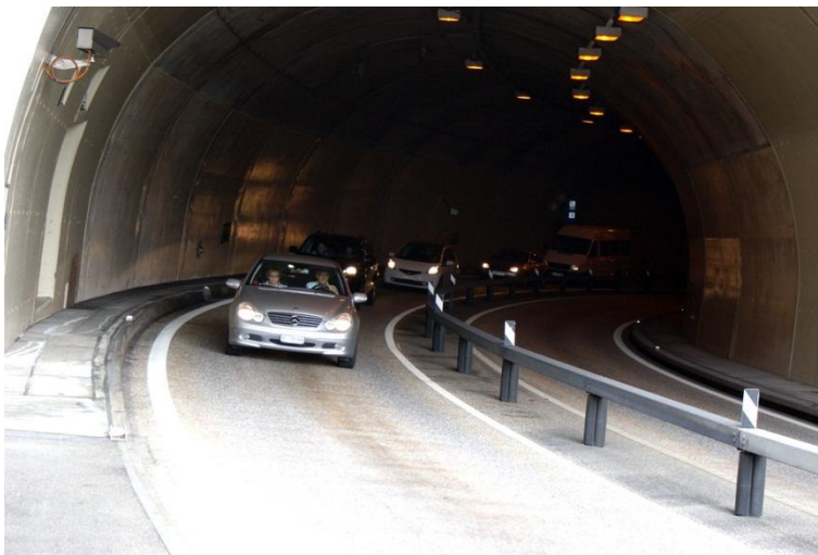
Abb. XI.40 Tunnel mit Leitschranke, Brünigpass
