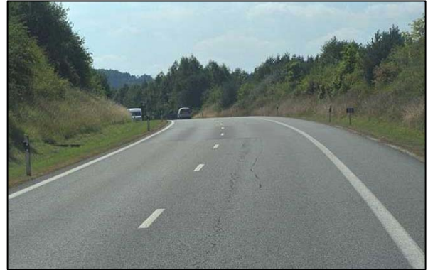
Figure 19 : Exemple d'incohérence des éléments d'une route : route à circulation bidirectionnelle mais présentant un profil autoroutier
