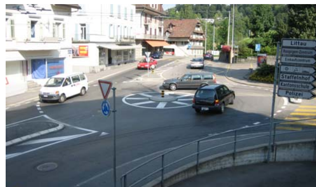
starke Beanspruchung der Markierung aufgrund Schubspannungen
