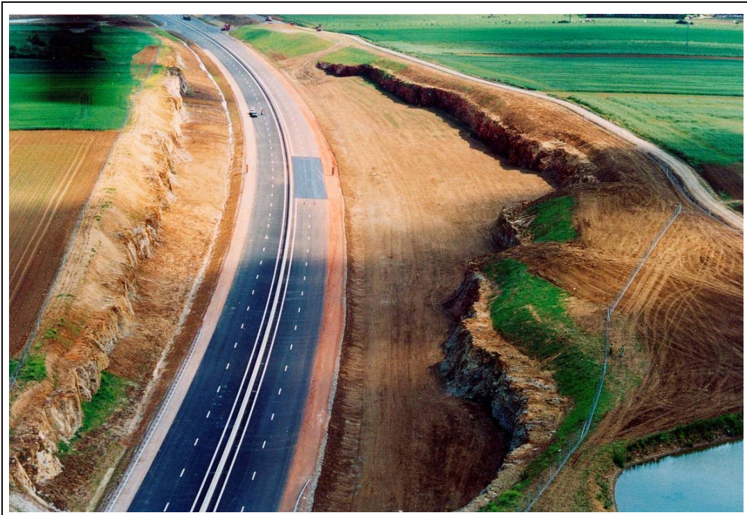
Figure 6 : utilisation d'un modelé de terrain pour diversifier le paysage routier (présentation de M. Lassus)
