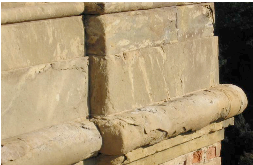
Fig. 133.4 Exemple d'altération en pelures d'oignon d'un grès sur un bâtiment historique de la région de Fiesole en Italie. Les parties exposées du bâtiment sont particulièrement touchées par les phénomènes d'altération. L'altération sous forme de pelure d'oignon est très caractéristique des grès.
