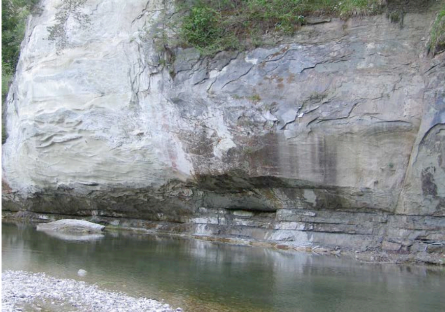
Fig. 133.12 Bancs de grès molassiques dans la vallée de la Sarine dans le canton de Fribourg. L'altération se présente sous forme de pelure d'oignon et d'effritement.
