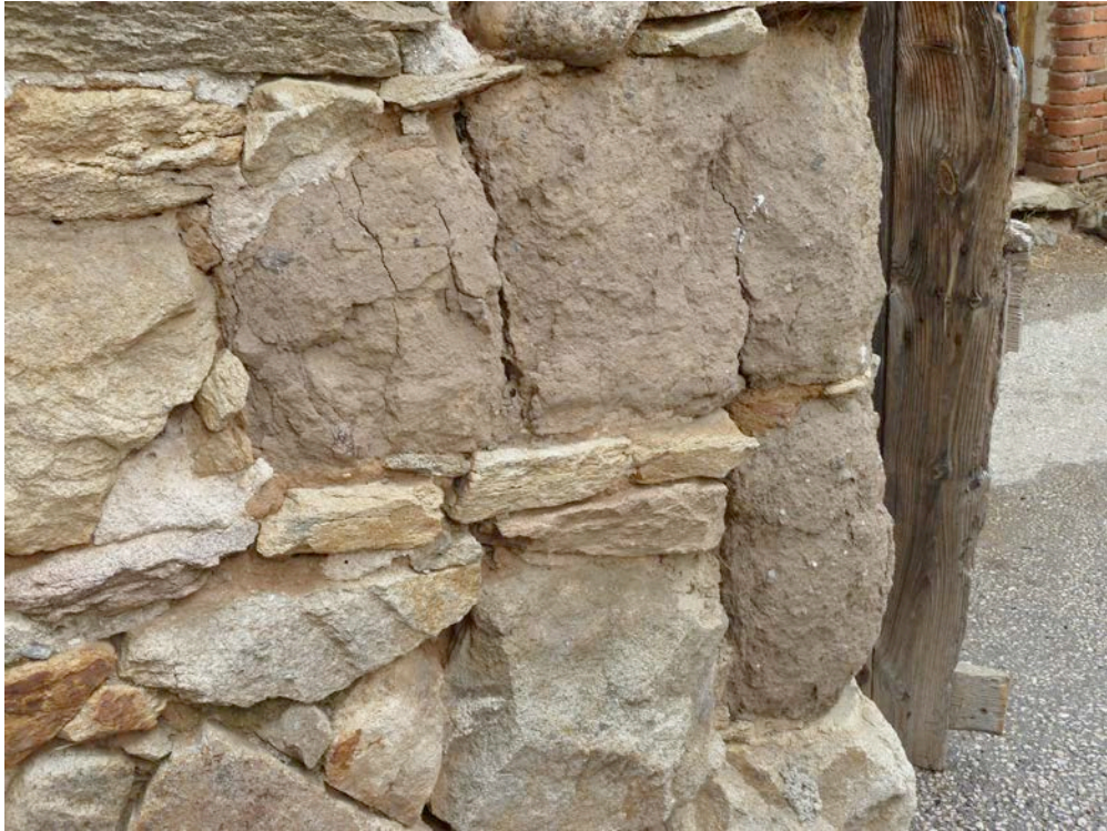
Fig. 133.3 Exemple de blocs sensibles aux intempéries dans un village protégé de Haute-Loire en France. L'altération se présente sous forme de pelure d'oignon et de fissuration. Le choix et l'emplacement des éléments gélifs sont peu judicieux. Des coûts de réfection dus à l'altération prématurée sont inévitables.
