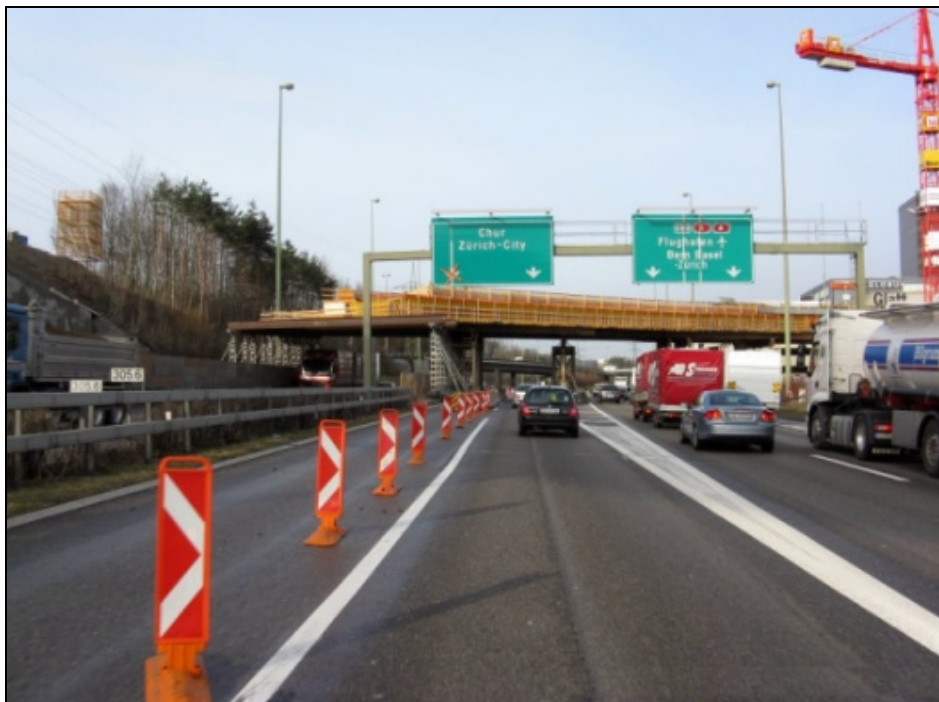
Abb. 21 Autobahn Baustelle (c) TCS Schweiz, 2010
