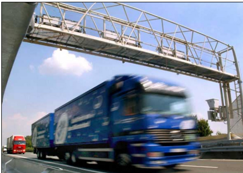
Abb. 19 Baken für die Kontrolle der LSVA (c) dpa, 2006
