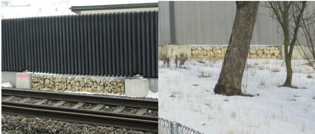
**Abb. 7** Gabione der Ausführungsvariante A von der Gleisseite aus gesehen. Rechte Seite: von der LSW-Aussenseite aus gesehen.
