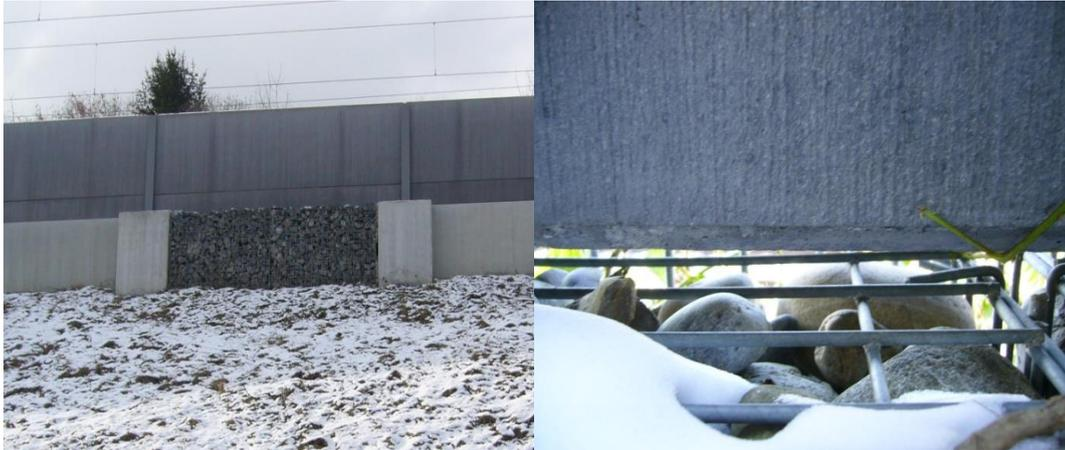
**Abb. 8** Gabione in der Ausführungsvariante B von LSW-Aussenseite des Hangs aus gesehen. Rechte Seite: typische Lücke zwischen eingebauter Gabione und lärmabsorbierenden Betonelement der LSW.
