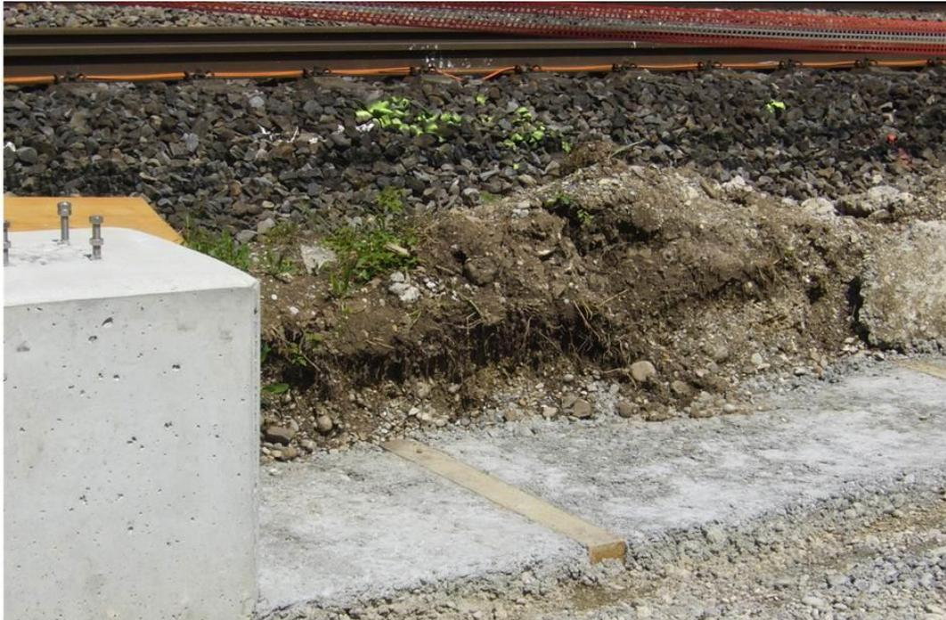
**Abb. 39** Eine Gabione wird in die LSW integriert. Die Aufstellfläche der Gabione wird dafür betoniert.
