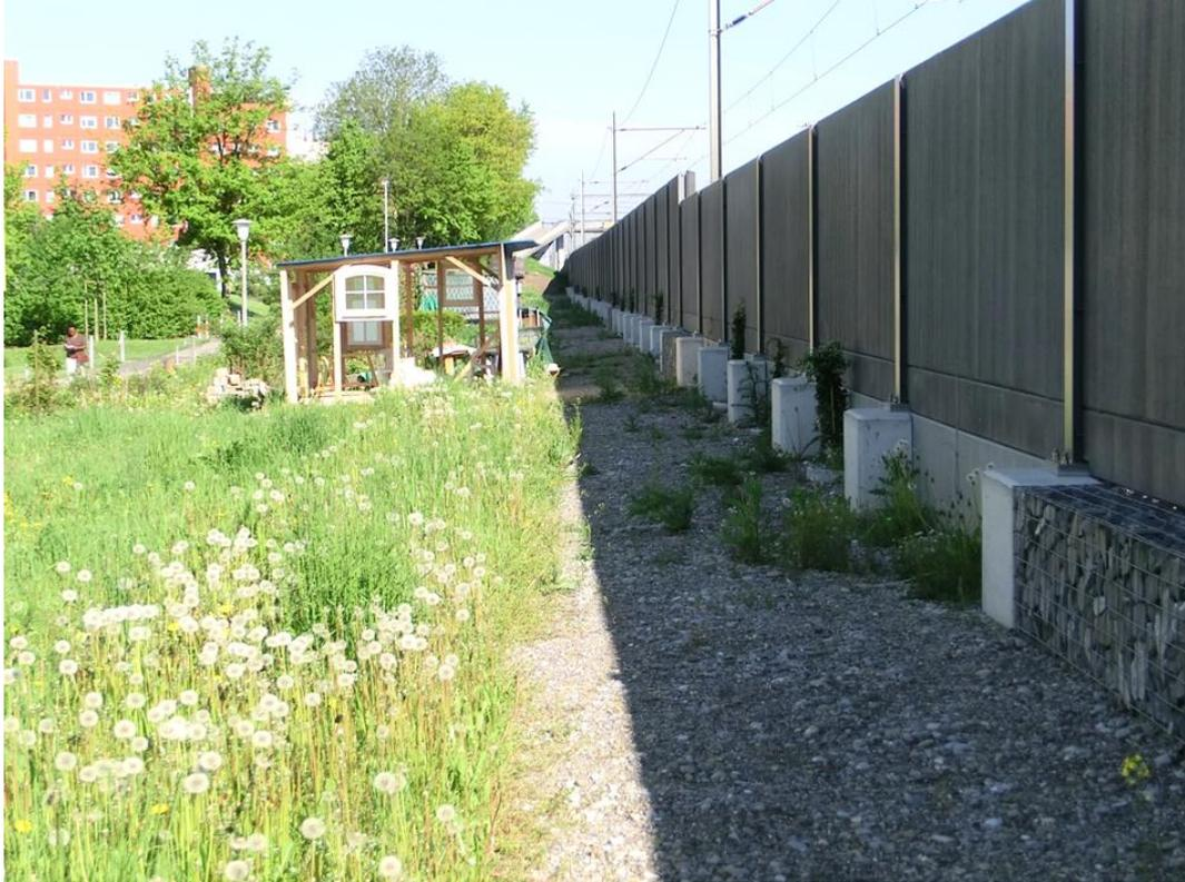
**Abb. 36** LSW in Nänikon ein Jahr nach dem Bau. Die eingebauten Gabionen sind noch nicht in das Böschungshabitat integriert. Der Schatten auf der abgebildeten Seite der LSW verschwindet kurz nach Sonnenaufgang.
