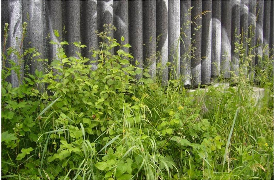
**Abb. 38** Ungepflegte, zugewachsene Gabione an einer LSW in Opfikon (Die Gabione ist nicht mehr zu erkennen).
