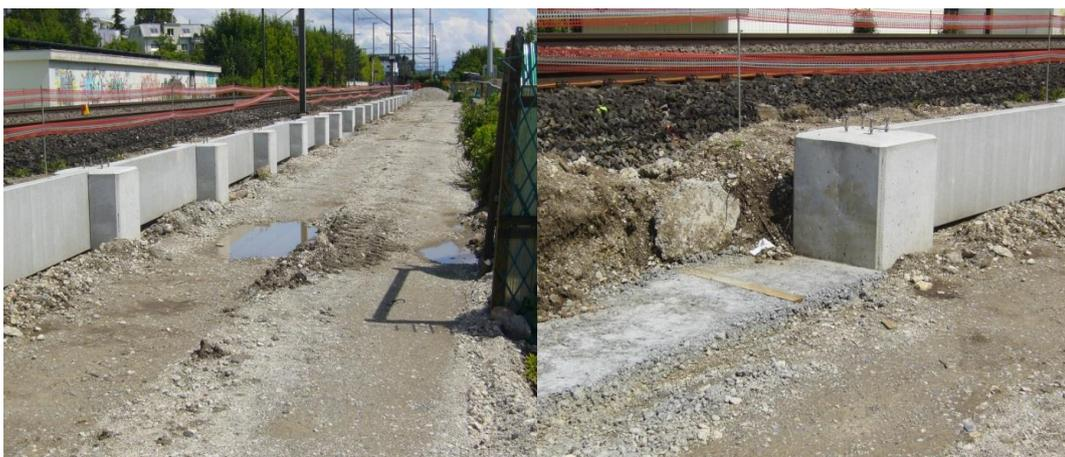
**Abb. 6** In den Boden eingelassene Stützelemente mit dazwischen eingehängten Betonelementen. Rechte Seite: anstelle des hier fehlenden Betonelementes wird eine Gabione eingebaut.
