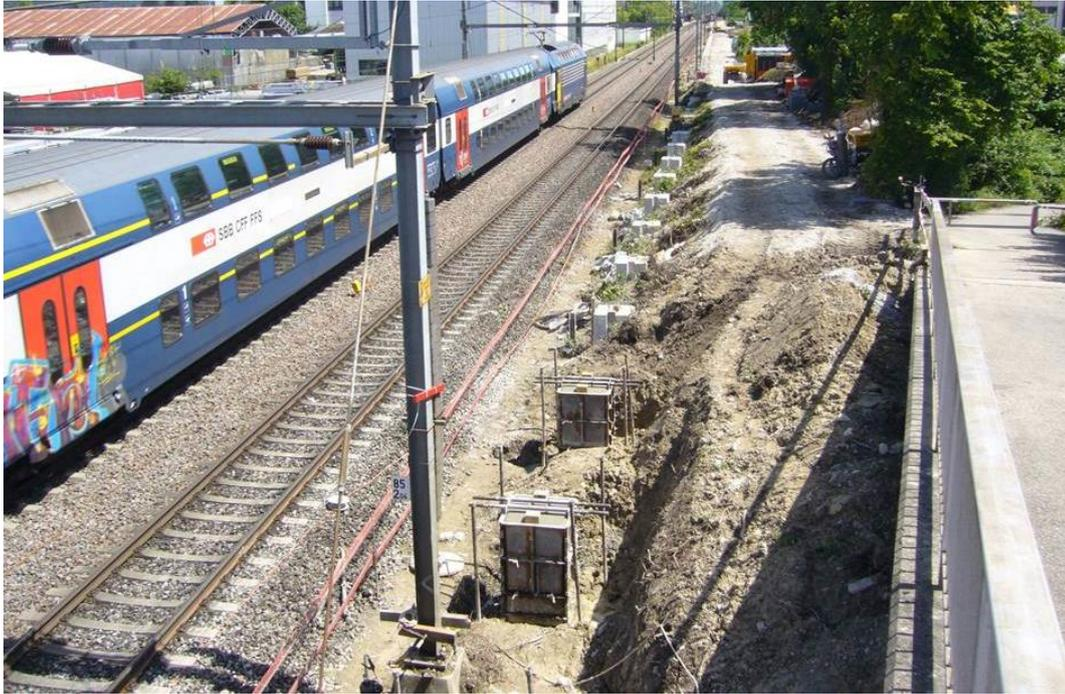
**Abb. 43** LSW im Bau bei Nänikon (ZH). Die ehemalige Böschung ist umgegraben und komplett zerstört.
