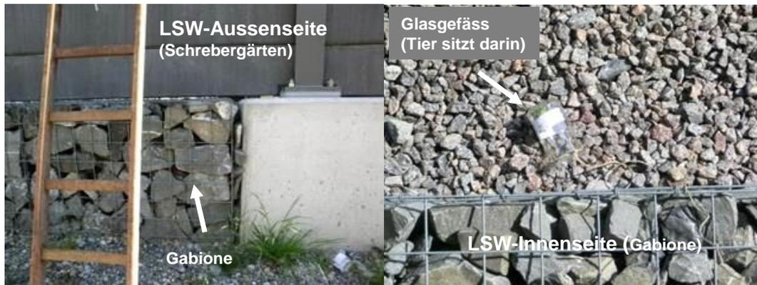
**Abb. 13** Linke Seite: Gabionen-Ausführungsvariante A von der Schrebergartenseite aus gesehen. Diese Gabione muss entweder erst erklettert werden, bevor eine bestehende Sichtlücke zum Überqueren benutzt wird, oder sie muss über das Hohlraumsystem blind durchquert werden. Rechte Seite: die Gabione auf der Gleisseite. Davor das Glasgefäss in dem das Tier transloziert wurde.
