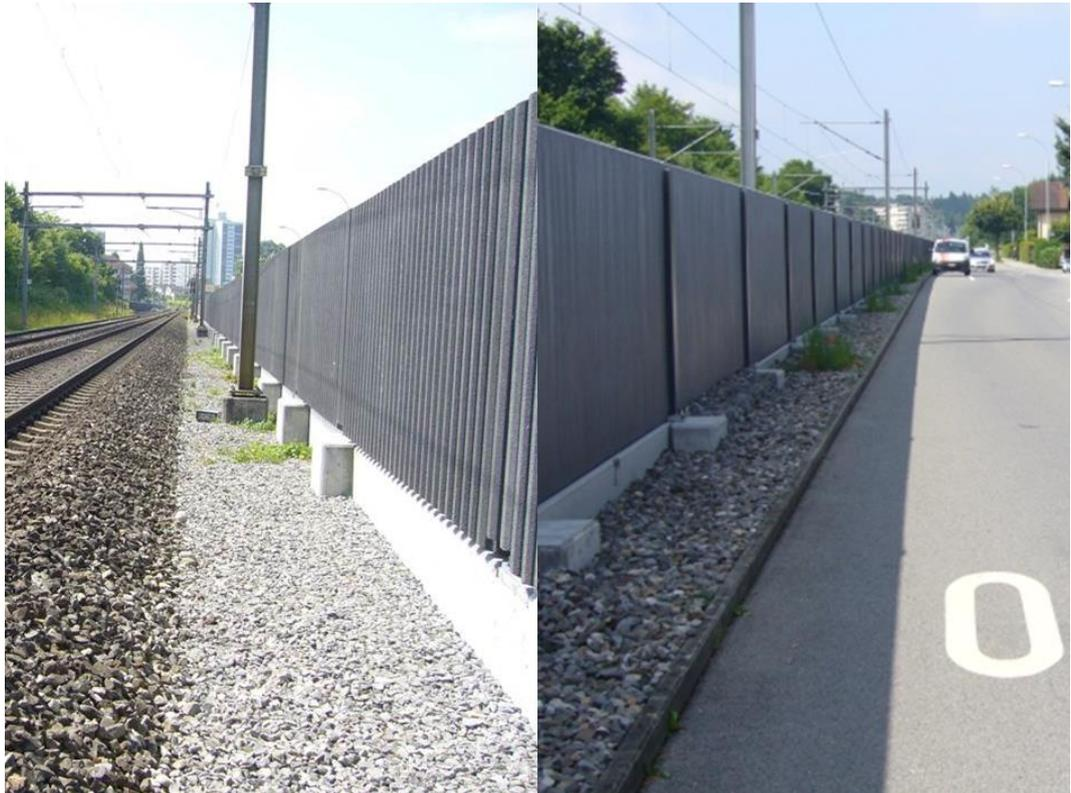
**Abb. 23** Bahnstrecke bei Rothenburg (LU) nach dem Bau der LSW. LSW-Innenseite links, LSW-Aussenseite rechts.
