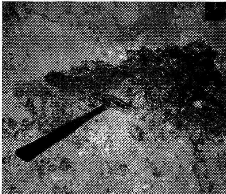
Figur 10: Äusserst mürber oberflächennaher Gewölbebeton mit stark reduzierter Festigkeit aus dem San Bernardino-Tunnel, mit einer Spitzhacke leicht ausschlagbar (Leitungskanal bei Block 1205, TM 3016).
