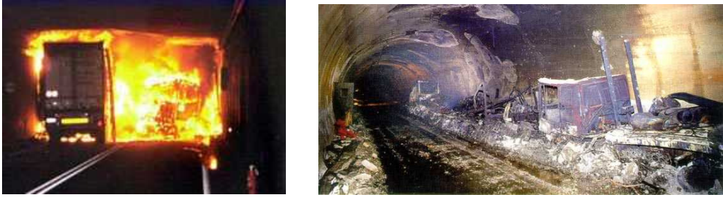
Abb. 1.1: Brandkatastrophen im Gotthardstrassentunnel (links) und Mont Blanc-Tunnel (rechts) führen zu grossen Schäden, die verhindert bzw. eingegrenzt werden sollen.
