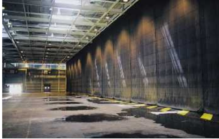
Abb. 2.7: Doppelwandige Feuerschutzvorrichtung im eingezogenen (links) und ausgefahrenen Zustand (rechts).
