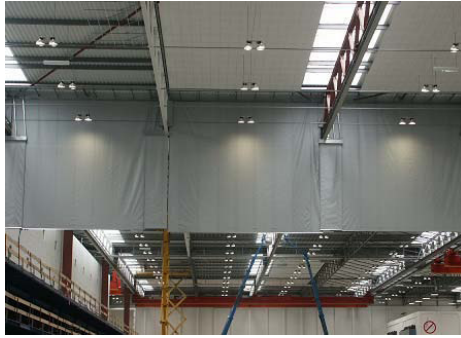
Abb. 2.3: Beispiel einer Schürzenvorrichtung (links) und eines Rauchschutzvorrichtung während des Schliessvorgangs (rechts).
