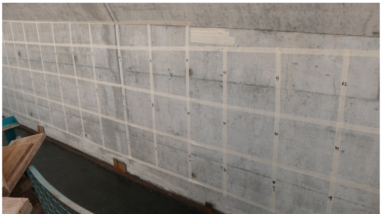
Abbildung C- 3: Messfelder der Etappe D-E
