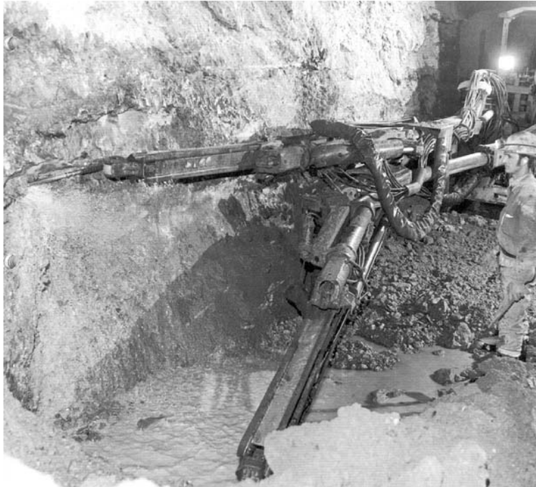
Bild 6-12 Pfändertunnel: Sprengtechnisch ausgeführter Strossenabbau. Bewässerung der quellfähigen Mergel durch das beim Erstellen der Sprenglöcher verwendete Brauchwasser ("Pfändertunnel", 1978)
