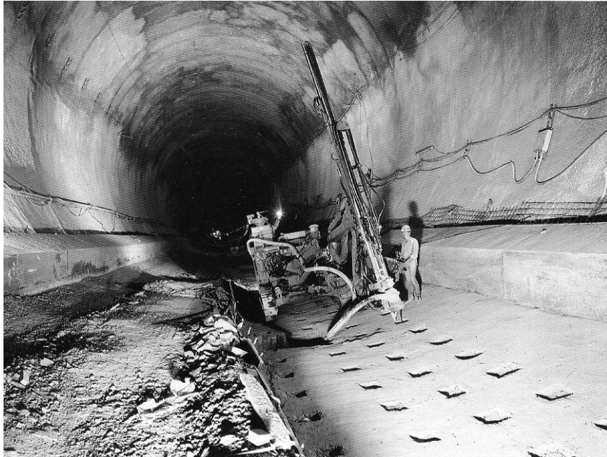
Bild 6-8 Freudensteintunnel: Versetzen von SN-Ankern in der Tunnelsohle zusätzlich zum provisorischen, 30 cm starken Ortsbeton-Sohlgewölbe in den als Nassbereiche eingestuften Tunnelabschnitten (Klonsdorf und Schaser, 1991)
