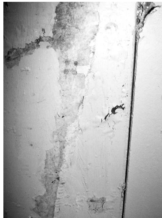
Bild 5-26 Adlertunnel: Beschädigung der Beschichtung der Tübbingge nach dem Einbau im Schildschwanz (Photo IGT, ETH Zürich)
