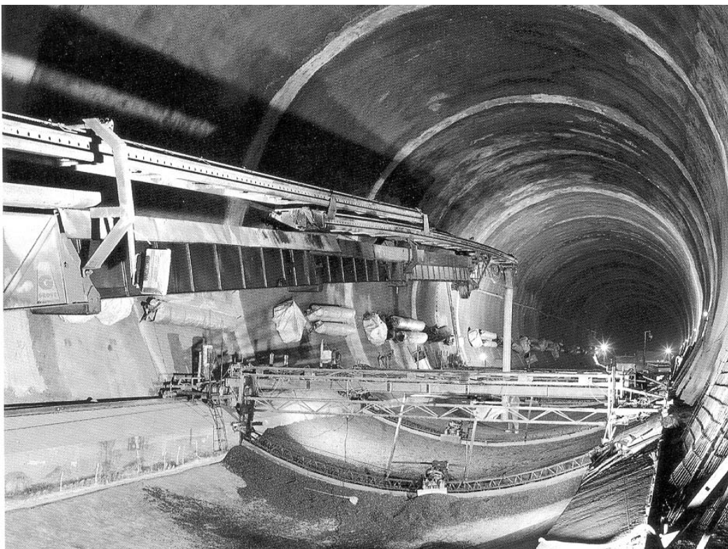
Bild 3-27 Freudensteintunnel: Lagenweiser Einbau des gebrochenen Blähtons in der 1,20 m starken Knautschzone (Photo aus Klonsdorf und Schaser, 1991)
