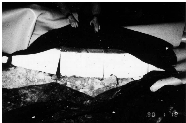
Bild 5-13 Gasstollen Cogefar (Italien): Verlegen der Abdichtungsfolie auf die in der Stollenssole verlegten Schaumstoffplatten.
