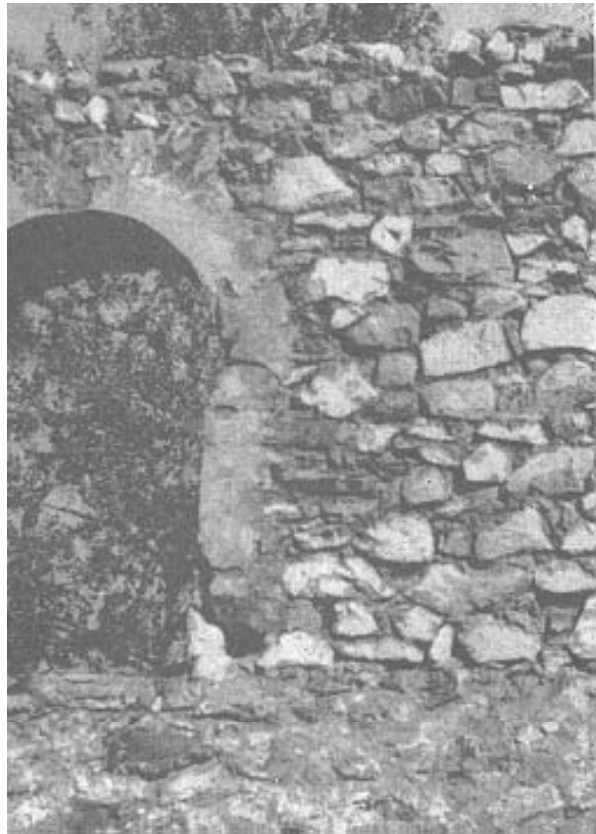
Bild 3-52 Mauerwerk aus Anhydrit-Bruchsteinen (Sahores, 1962)
