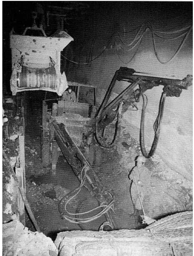
Bild 7-5 Erneuerung des Hauenstein-Basistunnels: Bohrarbeiten in der Tunnelsohle unter Einspurbetrieb im Baustellenbereich mit 200 Zügen pro Tag (Etterlin, 1987)
