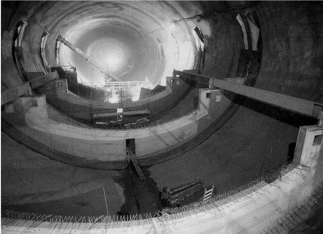
Bild 6-10 Engelberg-Basistunnel: Unterteilung des 3 m starken Sohlgewölbes mit Stirnscheiben, welche gleichzeitig als Blockfugen dienten (Foto aus Tunnel 8/1987)
