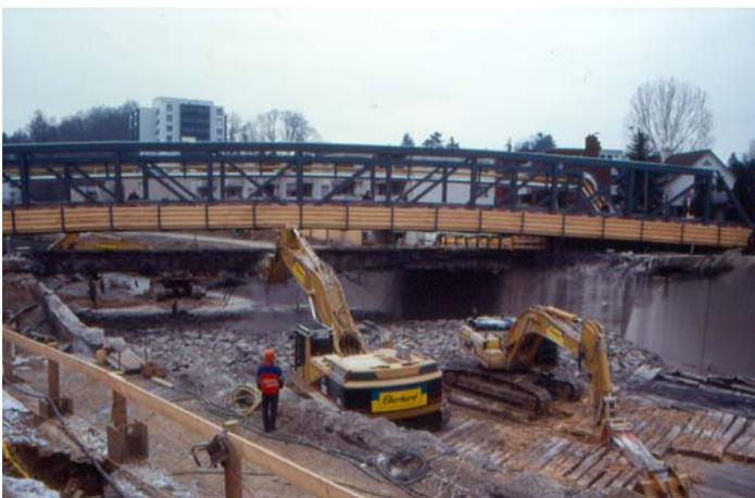
Bild 3.26 Abbruch mit *Abbauhammer* unter *Brückenprovisorium* (ZH 109)
