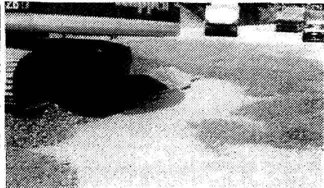
*Bild 8-4: Überdecken Vlies mit Wandkies als Schutzmassnahme*
