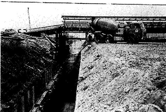
*Bild 6-4: Hinterfüllen der setzlichen Baugrube mit Sand*
