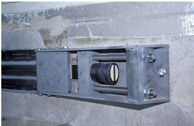
Abbildung 42: Detail Verankerung
