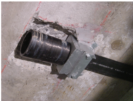
Abbildung 31: Einsetzen des Spanngliedes
