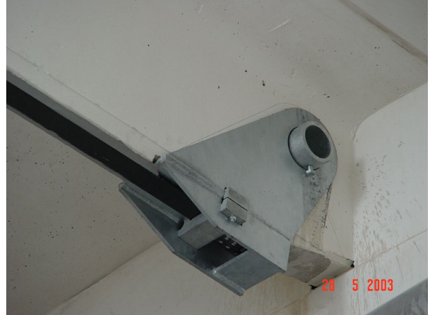
Abbildung 43: Bewegliche und feste Verankerung an den Stahlbeton-Dachbindern
