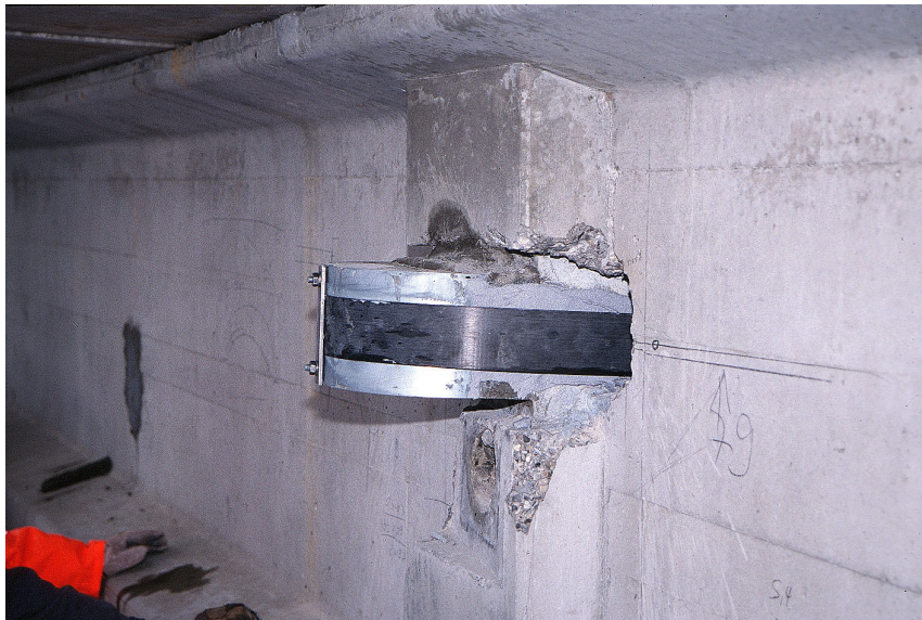
Abbildung 12: Umlenksattel am Randträger
