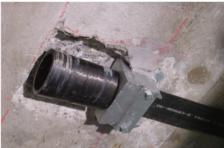
Abbildung 18: Feste Verankerung mit Schubdorn
