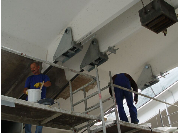
Abbildung 43: Bewegliche und feste Verankerung an den Stahlbeton-Dachbindern
