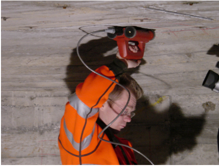
Abbildung 26: Bestimmen der Lage der Bewehrung
