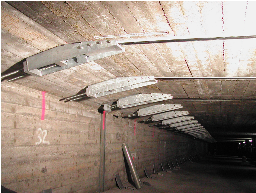
Abbildung 35: Bewegliche Verankerung bei der Voute
