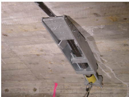
Abbildung 32: Spannen bei der beweglichen Verankerung
