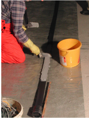
Abbildung 30: Reinigen des Spanngliedes und Auftrag des Klebers
