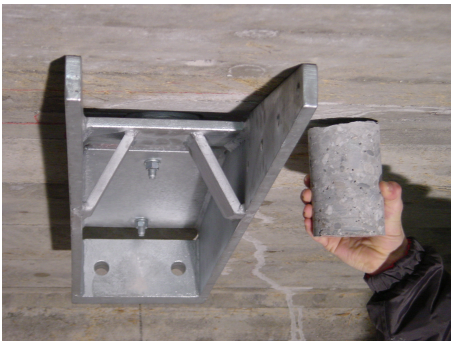
Abbildung 28: Bewegliche Verankerung versetzt
