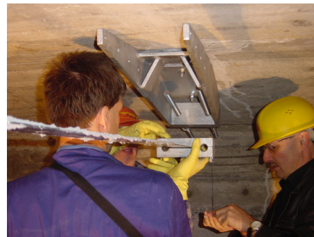
Abbildung 30: Reinigen des Spanngliedes und Auftrag des Klebers
