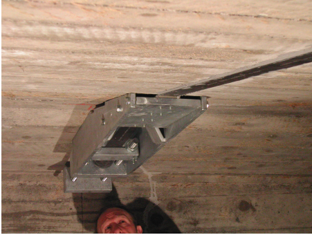
Abbildung 33: Vorgespanntes System nach Ausbau der Spannpresse
