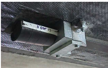
Abbildung 38: Feste Verankerung mit Gewebeerstärkung als Spreizbewehrung
