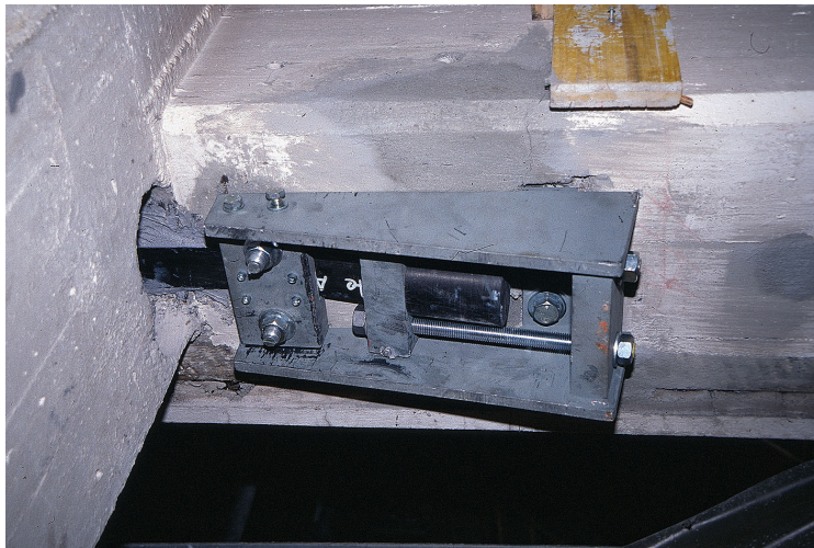
Abbildung 40: Detail bewegliche Verankerung
