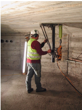
Abbildung 27: Kernbohrung
