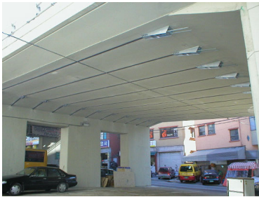
Abbildung 37: Vorgespannte CFK-Lamellen
