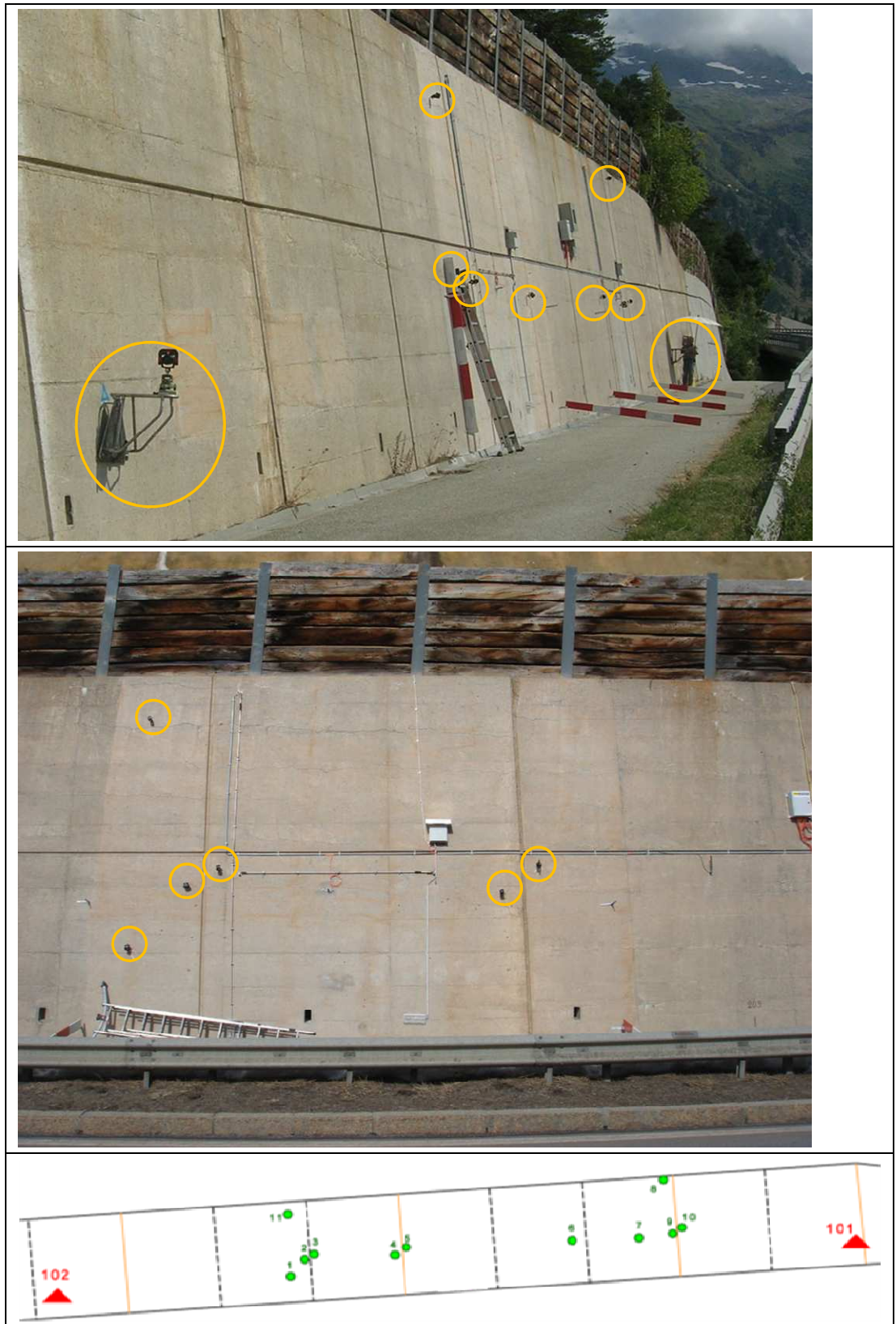
Abb. 3.12 Oben: S0751 Testfeld T1. Markiert sind die eingeschraubten Reflektoren für die Messungen durch den Geometer. Mitte: S0751, Testfläche T2. Unten: Verteilung der Messpunkte über den mittleren Teil der Stützmauer.
