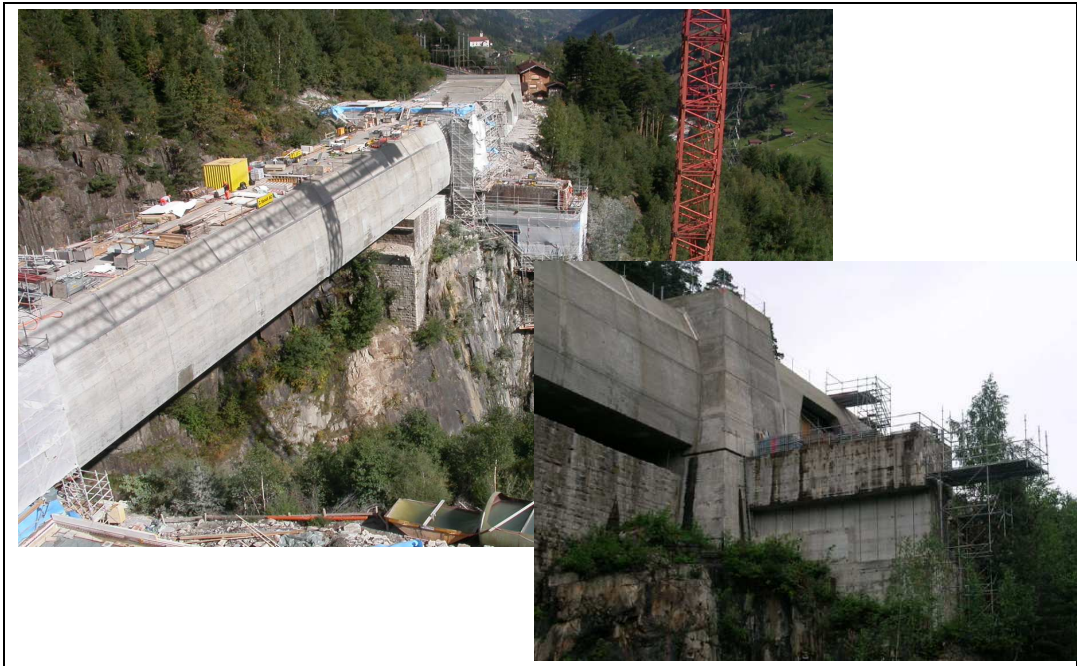
Abb. 3.18 Rorbachbrücke der SBB zwischen Wassen und Göschenen während der Instandsetzung 2007.
