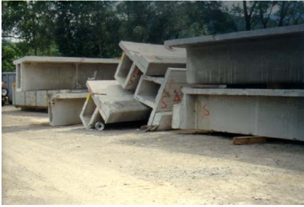
Abbildung 1.1.11: Brückenteile des Objektes 1 auf Deponie
