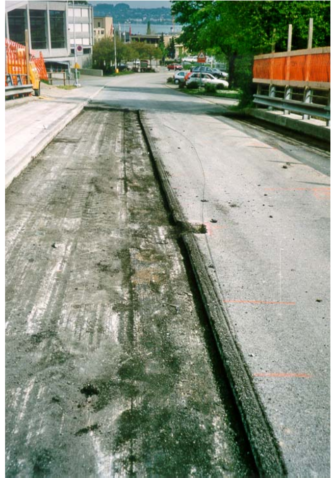
Abbildung 10.1.11: Fräskante, Spur Mitte, S2
