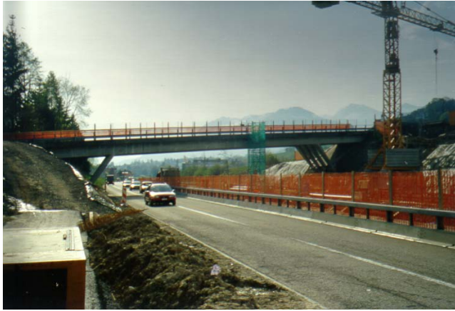
Abbildung 10.1.4: Brücke von Norden betrachtet
