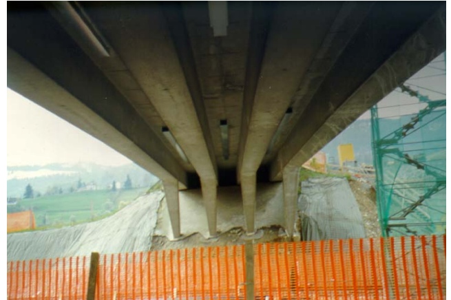
Abbildung 10.1.5: Brücke von unten betrachtet
