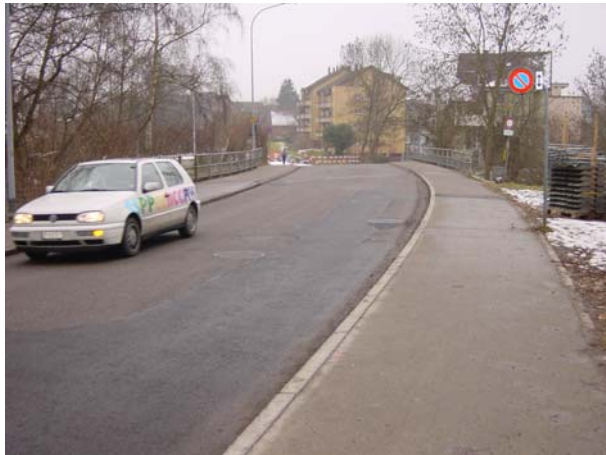
Abbildung 10.5.2: Fahrbahn von Norden betrachtet
