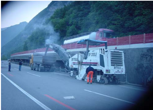
Abbildung 10.3.1: Abfräsen des Belages
