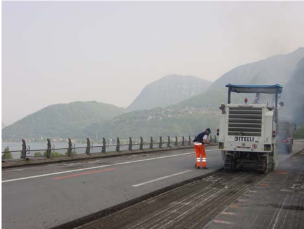
Abbildung 1.1.7: Abfräsen des Belages auf dem Objekt 3
