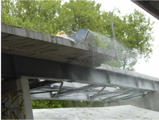
Abbildung 10.2.19: Betonabbruch
