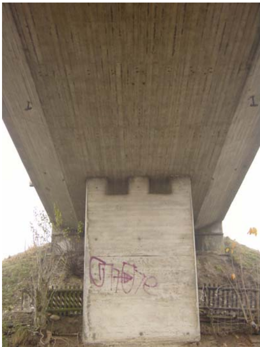
Abbildung 10.4.7: Brücke von unten betrachtet
