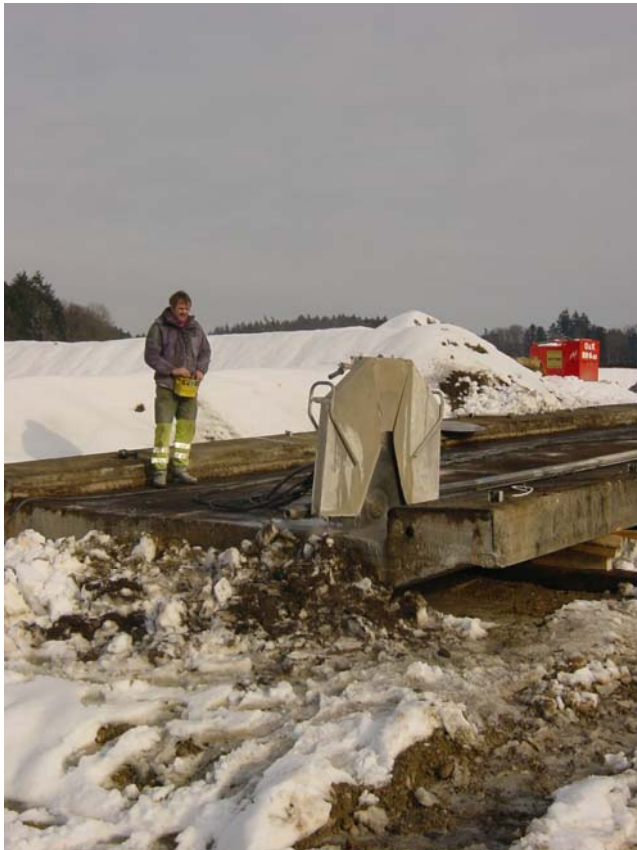
Abbildung 10.4.10: Schneiden der Brückenplatte
