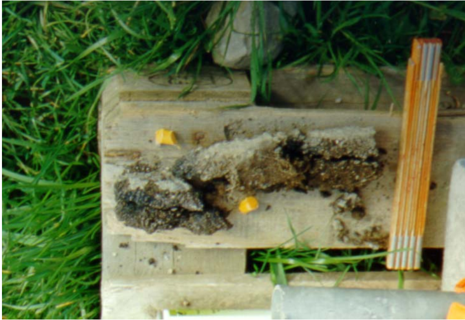
Abbildung 5.2.1: Belagsprobe von der Überführung Burggasse
