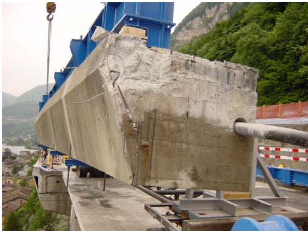
Abbildung 1.1.9: Entfernung eines Brückenteils vom Objekt 3
