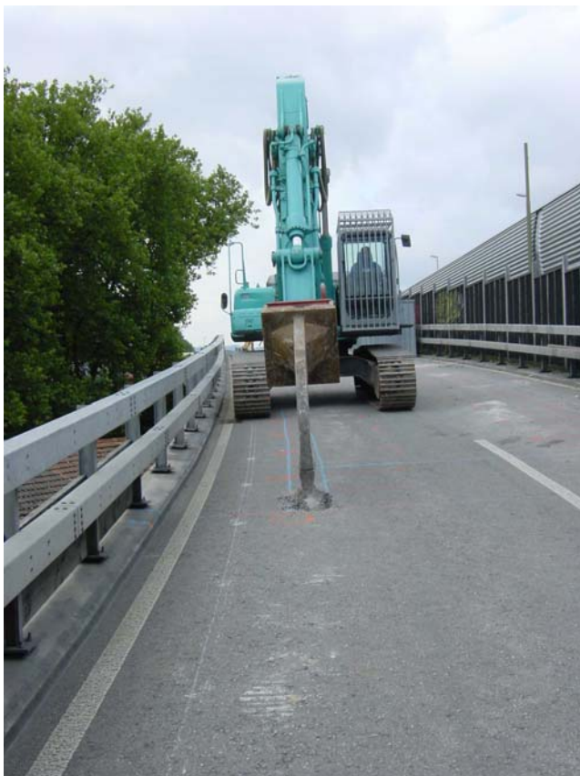
Abbildung 10.2.13: Öffnen des Belages
