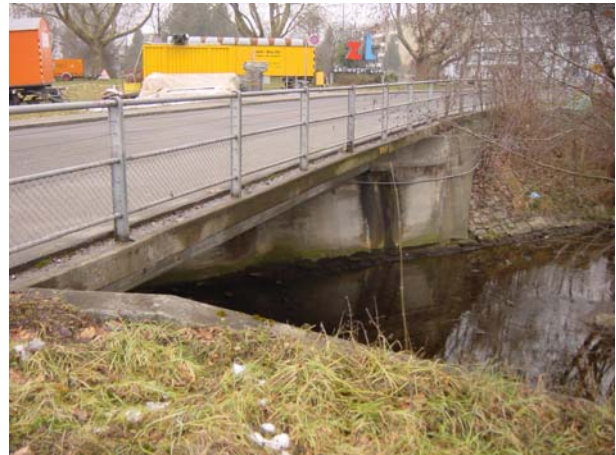
Abbildung 10.5.3: Seitenansicht von Osten betrachtet
