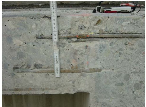
Abbildung 1.1.10: Ausmessen der Eisenüberdeckung an einem Teil des Objekts 3
