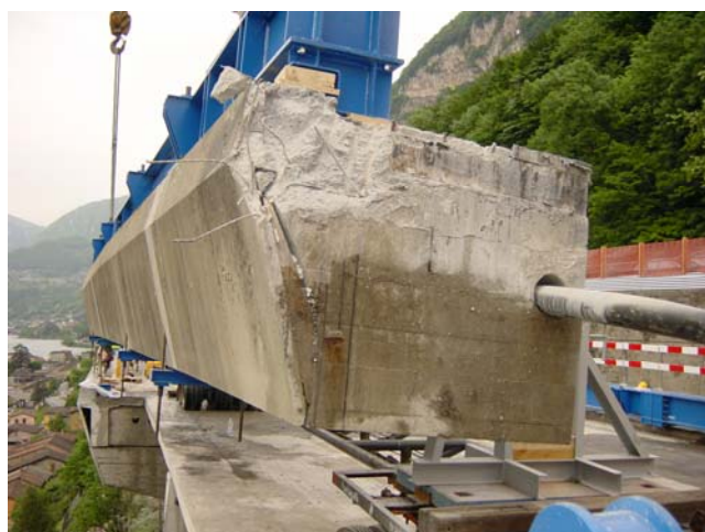
Abbildung 10.3.5: Betonabbruch
