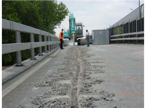
Abbildung 1.1.8: Belagsöffnung mittels Baggerzahn auf Objekt 2
