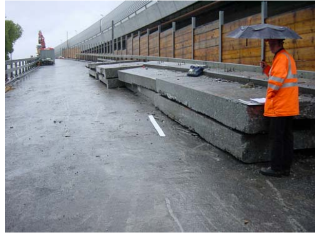
Abbildung 10.2.20: auf der Brücke abgelegte Brückenteile
