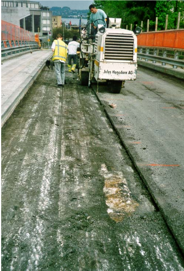
Abbildung 10.1.10: Abfräsen des Belags
