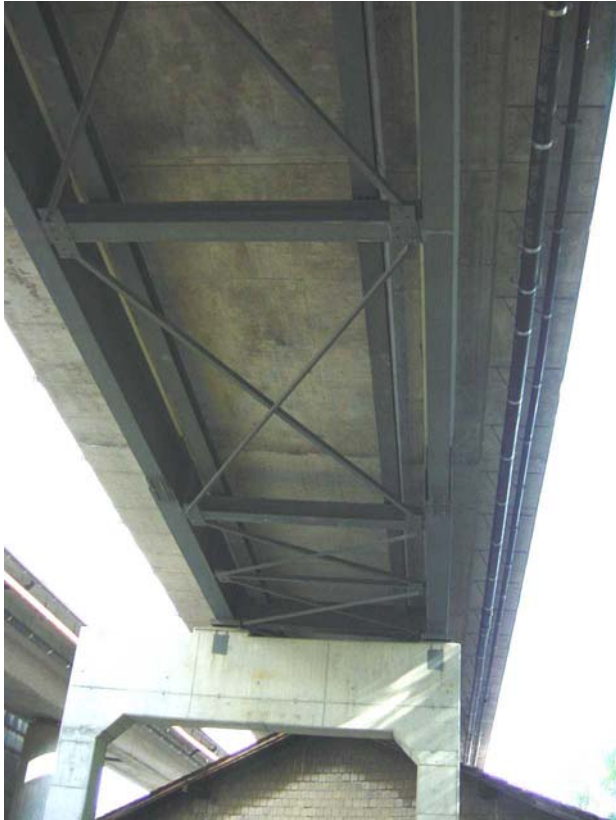
Abbildung 10.2.6: Brücke von unten betrachtet
