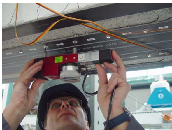
Abbildung 66: Deformetermessung an Trägerunterseite
