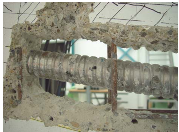
Abbildung 31: geöffnete Sondierstelle mit sichtbarem Hüllrohr
