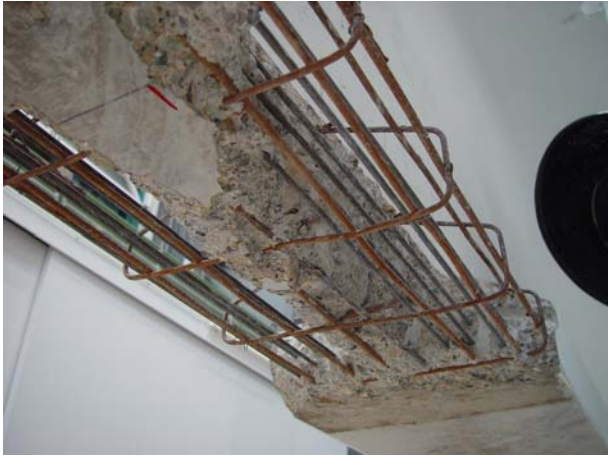
Abbildung 20: Aufgespitzter unterer Flansch mit konstruktiver Bewehrung und Spannbettdrähten
