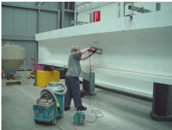
Abbildung 30: Aufspitzen einer Sondierstelle
