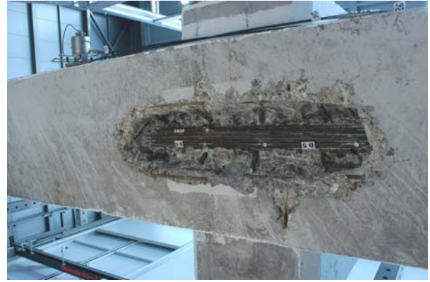
Abbildung 33: Sondierstelle Nr. 2 an Trägerunterseite
