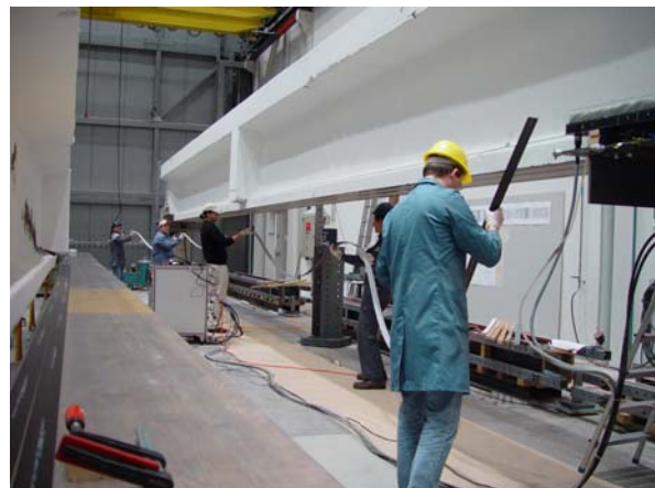
Abbildung 80: Träger 2, Anbringen der CFK-Lamellen
