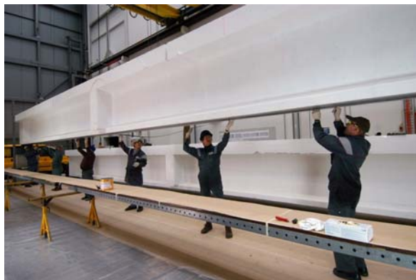
Abbildung 74: Ankleben der 15.5 m langen CFK-Lamellen benötigt kurzfristig mehrere Personen
