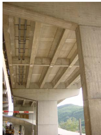
Abbildung 3: Untersicht der Brücke „Viadotto delle Cantine a Capolago“
