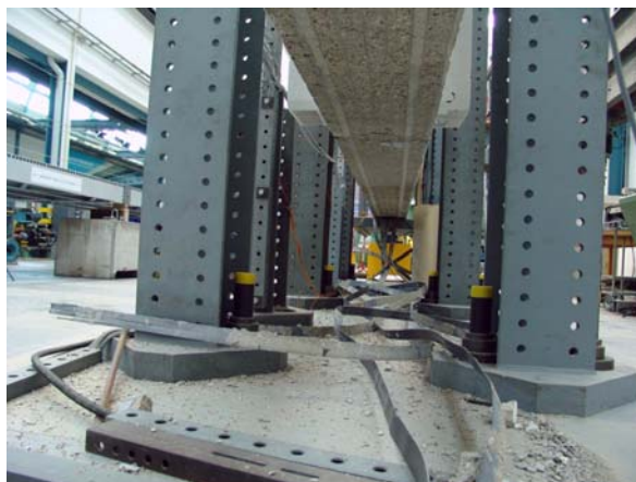
Abbildung 106: Unterseite des Trägers 2 am Tag nach Bruchversuch
