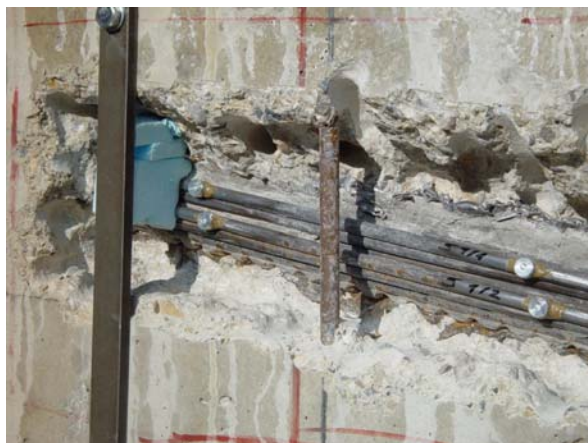
Abbildung 39: Sondierstelle bei Träger 5 zur Ermittlung der noch vorhandenen Vorspannung
