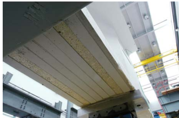
Abbildung 98: Träger 4, Endbereich nach dem Bruch, Klebschicht noch vorhanden
