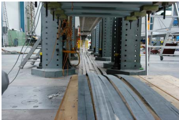
Abbildung 97: Träger 4, delaminierte CFK-Lamellen
