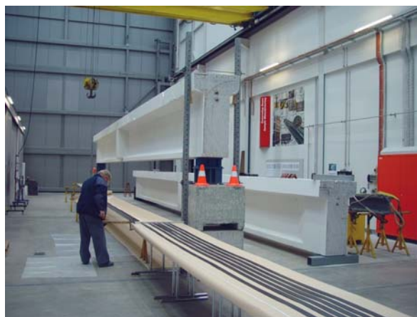
Abbildung 72: Vorbereitungen zum Kleben der 6 Stück CFK-Lamellen à je 15.5m Länge
