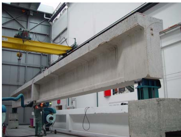
Abbildung 71: Die Betonoberfläche (hier Träger 4) wurde vorgängig mit einem Schleifgerät aufgeraut.
