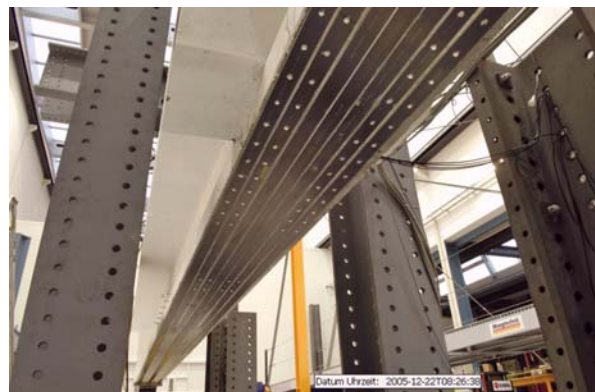
Abbildung 88: Untersicht des Trägers 5, alle CFK-Lamellen sind angeklebt
