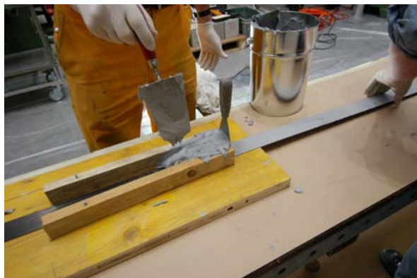
Abbildung 73: Applikation des Klebers auf die CFK-Lamellen beim Träger 4
