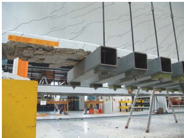
Abbildung 107: Träger 2, Verankerungszone nach dem Bruch
