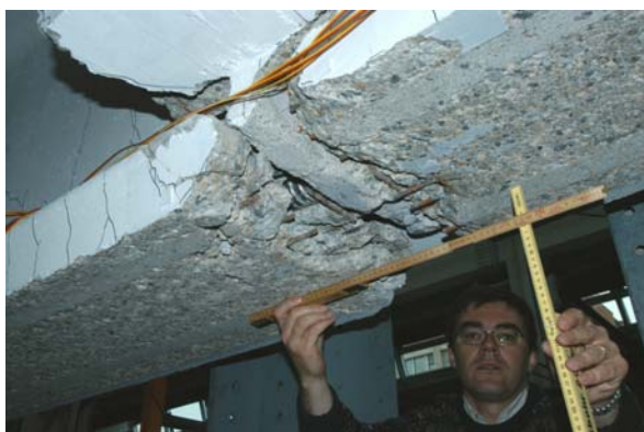
Abbildung 65: Mittelfuge mit Mörtelvorlage (Träger 4)
