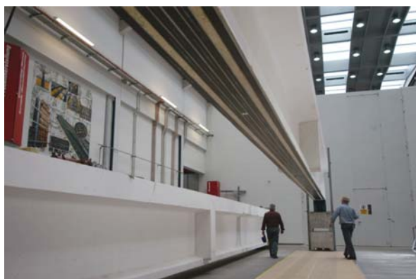
Abbildung 75: Träger 4, Blick von unten, 6 Stück angeklebte CFK-Lamellen
