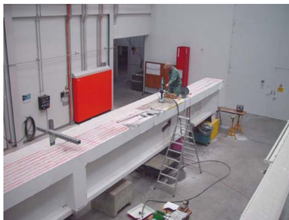
Abbildung 25: Bohrkerntnahme im Flansch
