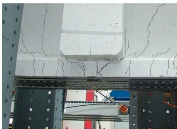
Abbildung 101: Träger 2, (stabil) abgelöste CFK-Lamellen in Trägermitte kurz vor Bruch
