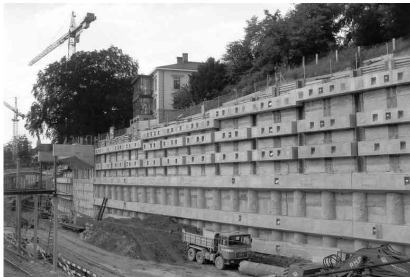
Bild 1.1: Stützmauer Bahnhof Stadelhofen (1986)
