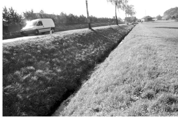
Bild 12: Hauptverkehrsstrasse mit Entwässerung über Böschung in oberirdisches Gewässer
