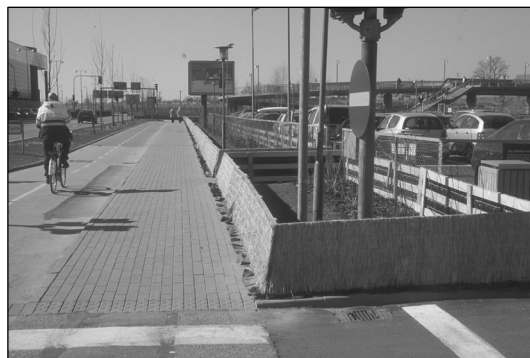
Fig. 27 : Parois de protection contre l'eau projetée en bois au Danemark
