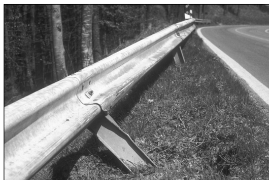
Fig. 22 : Glissières avec encastrement insuffisant dans le sol
