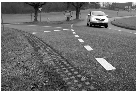
Bild 19: Mit Rasengittern verstärktes Bankett in der Schweiz
