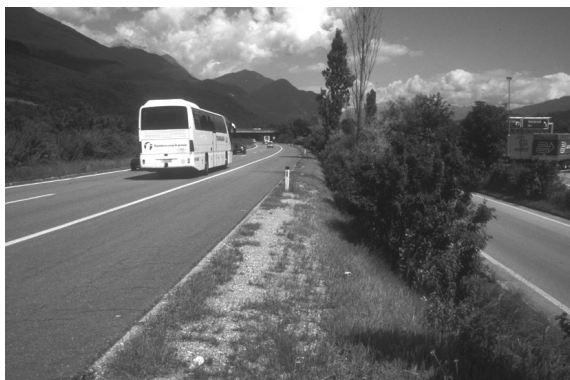
Bild 15: Entwässerung in den Mittelstreifen einer Hochleistungsstrasse
