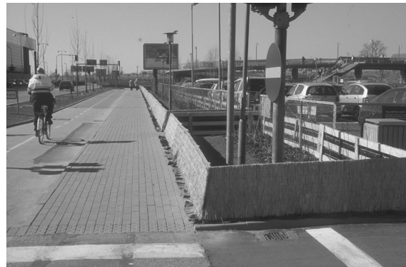
Bild 27: Spritzwasser-Schutzwände aus Holz in Dänemark
