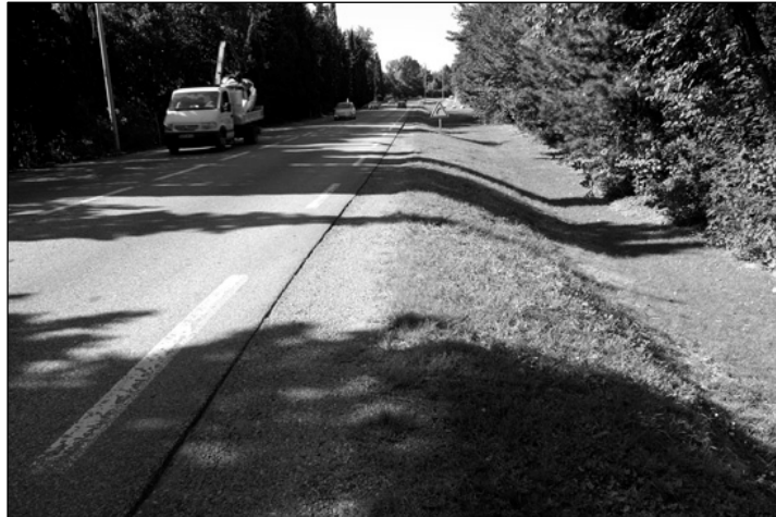
Fig. 10 : Route avec un accotement en argile (!)
