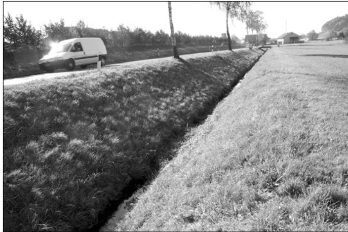
Fig. 12 : Route principale avec évacuation des eaux sur le talus dans des eaux superficielles
