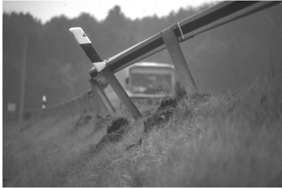
Bild 21: Leitschranke mit ungenügend steifer Einspannung in schmalem Bankett in der Schweiz
