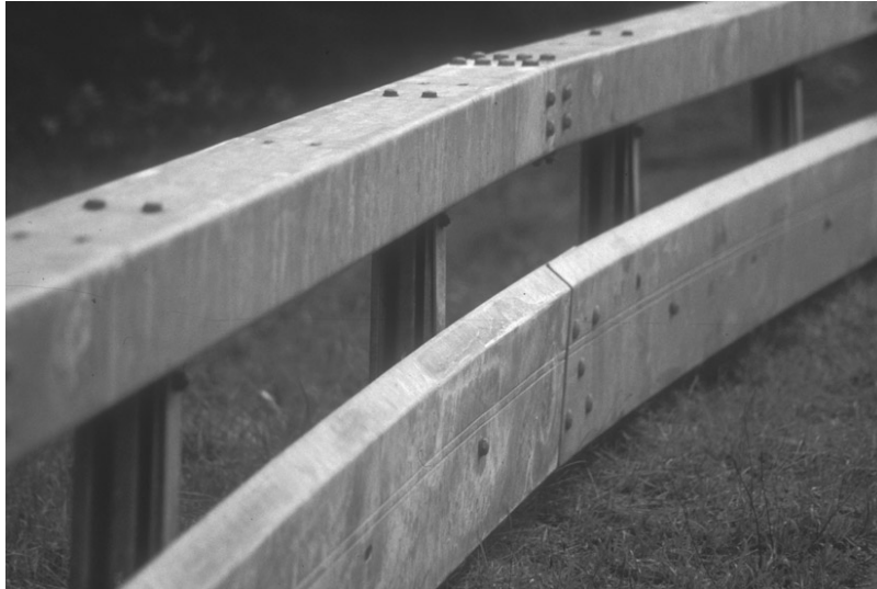
Bild 23: Leitschranke mit Kastenprofil LS 150'180u modifiziert mit Unterfahr-schutz, verwendbar auch als Spritzwasser-Rückhalte-system
