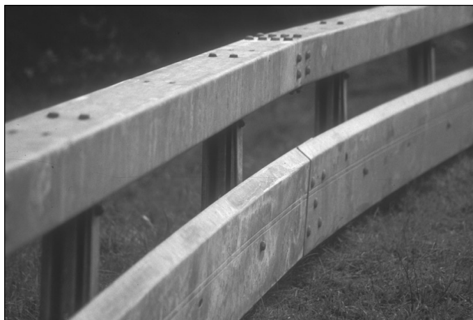
Fig. 23 : Glissière de sécurité avec profil en caisson LS 150'180u modifiée avec protection contre un passage par-dessous utilisable aussi comme système de retenue des eaux projetées
