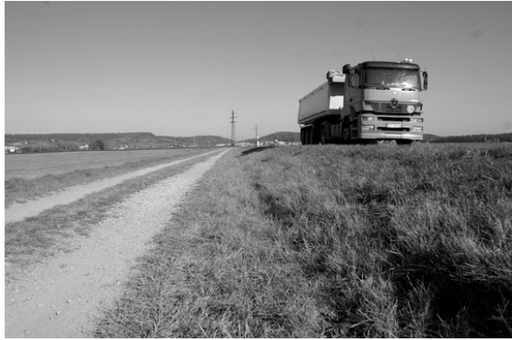
Bild 11: Hauptverkehrsstrasse mit Entwässerung über die Böschung
