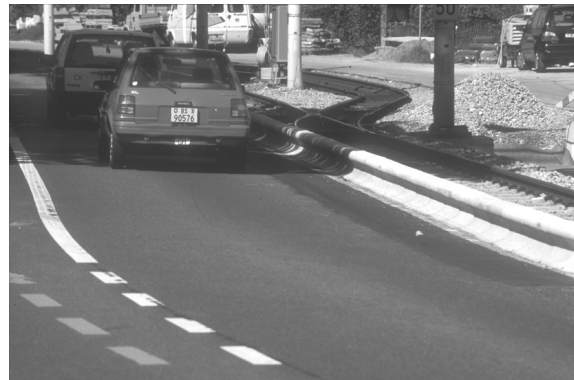
Bild 25: Leitbord in Schutzzone in der Schweiz, System aus Frankreich übernommen
