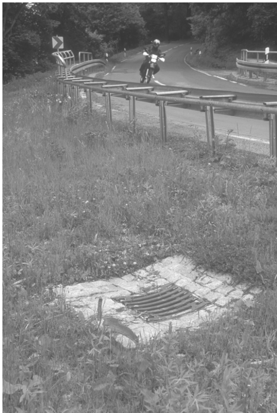
Bild 16: Ablauf mit beschränkter oder ohne Wirkung unter Böschung
