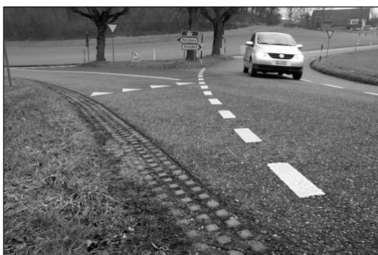
Fig. 19 : Accotement renforcé par des grilles-gazon en Suisse
