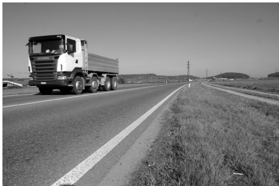
Bild 13: Hauptverkehrsstrasse mit Entwässerung in Sickerstreifen
