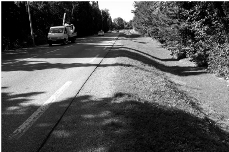
Bild 10: Strasse mit Bankett mit toniger Deckschicht
