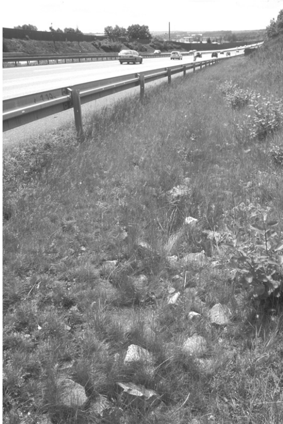
Bild 5: Entwässerung einer Hochleistungsstrasse in bewachsenen Graben
