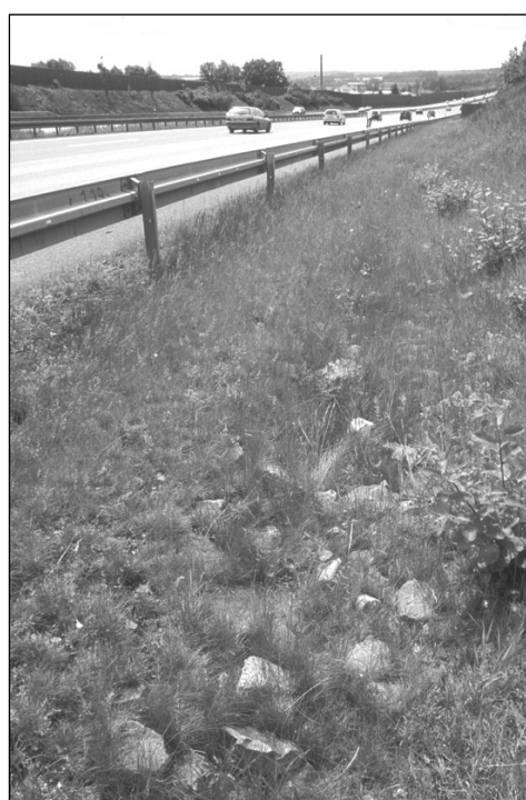
Fig. 5 : Évacuation des eaux d'une route à grand trafic vers un fossé végétalisé
