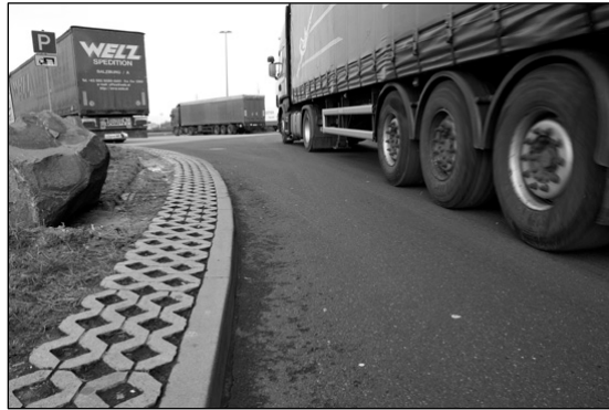
Fig. 20 : Bas-côtés souvent utilisés et renforcés par des grilles-gazon en Allemagne
