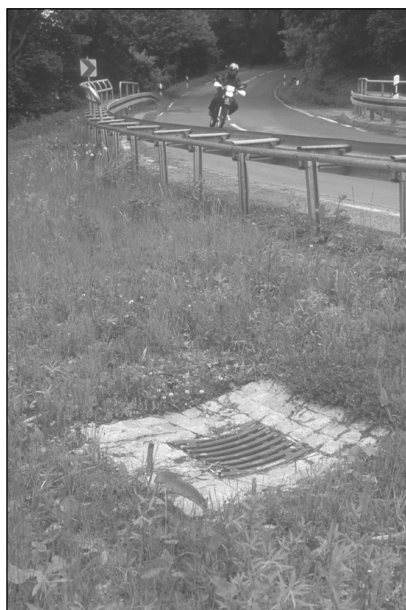
Fig. 16 : Regard ou cheminée d'évacuation des eaux en pied de talus
