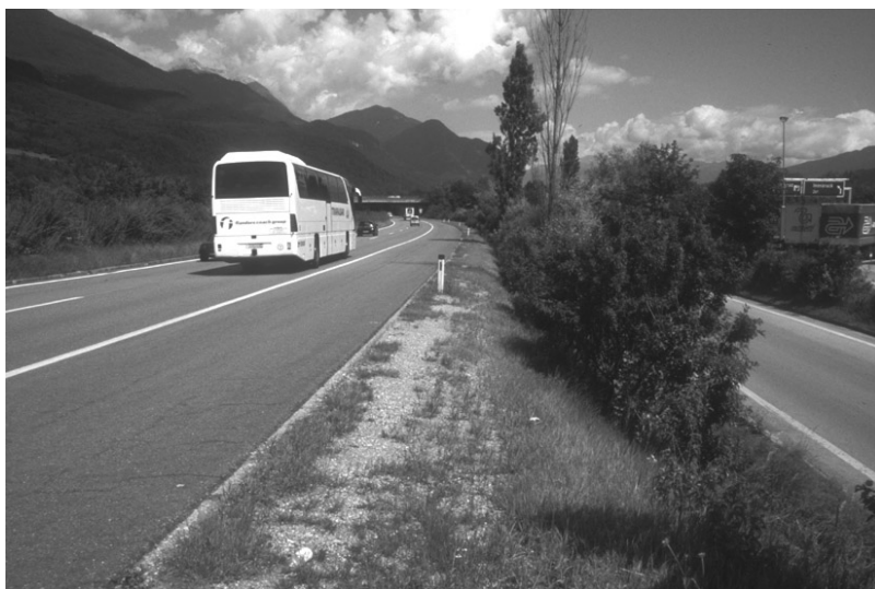
Bild 4: Entwässerung in Autobahnmittelstreifen
