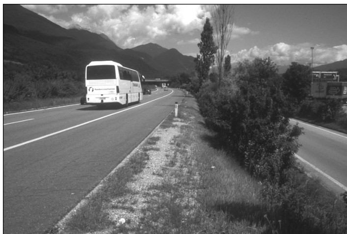
Fig. 4 : Évacuation vers la bande médiane de l'autoroute
