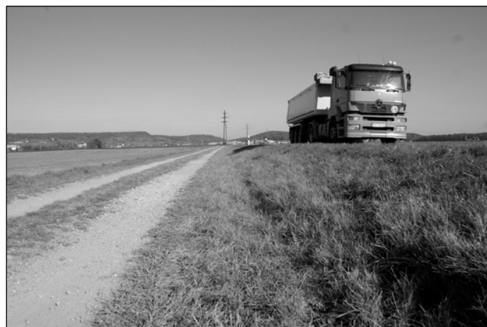
Fig. 11 : Route principale avec évacuation des eaux sur le talus
