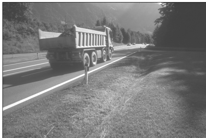
Fig. 14 : Route principale avec évacuation des eaux dans un fossé
