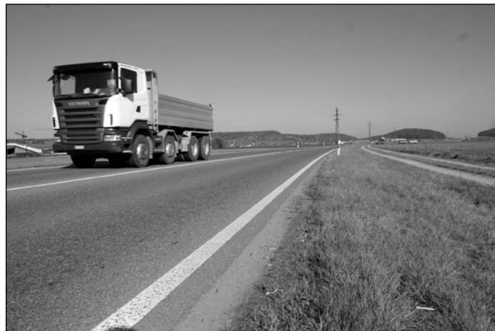
Fig. 13 : Route principale avec évacuation des eaux dans un fossé drainant
