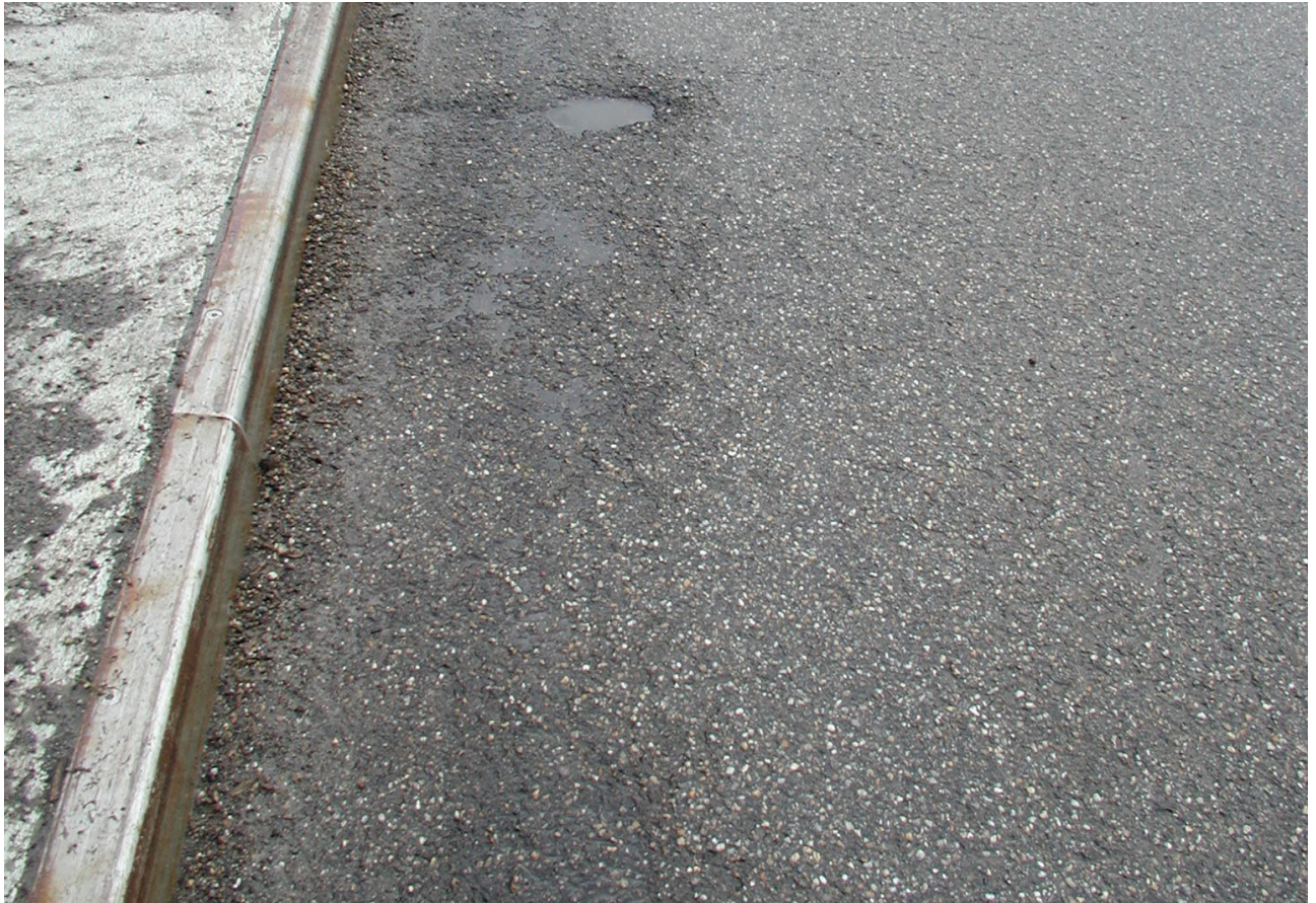
Fig. 11.7: revêtement du pont de Rossei à fin mars 2005. Les dégradations dans le revêtement ont atteint un état avancé, la surface du revêtement est fortement désagrégée par endroit et des nids de poule se sont développés.
