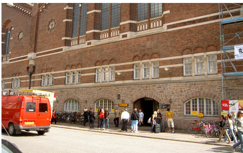
Abbildung 28: Hauptbahnhof Kopen- hagen, Hauptzu- gang Vesterbro- Seite: Zugänge sind klein und kaum auffindbar. Ausser- dem fehlt Platz für die Fussgänger.
