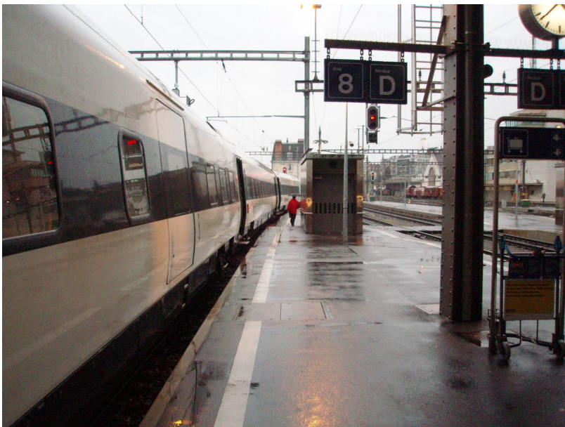
Abbildung 34: Periphere Perronbereiche sind oft nicht wettergeschützt.
