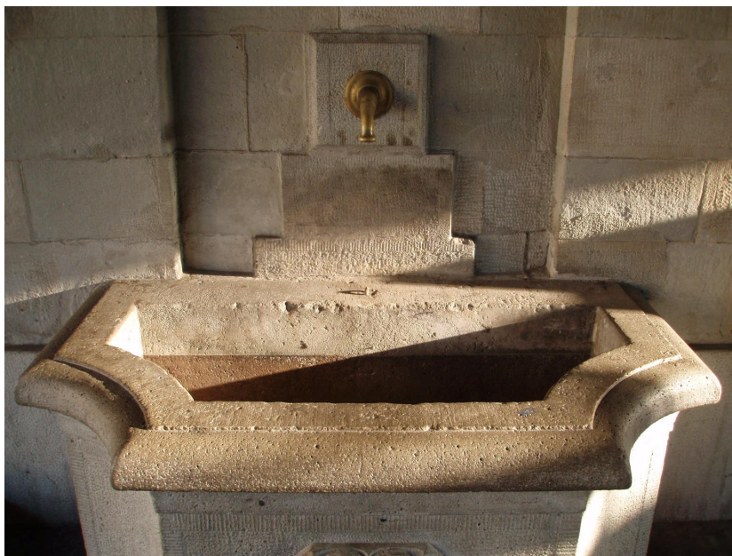
Abbildung 30: Der stillgelegte Trinkwasserbrunnen beim Bahnhof Brugg.
