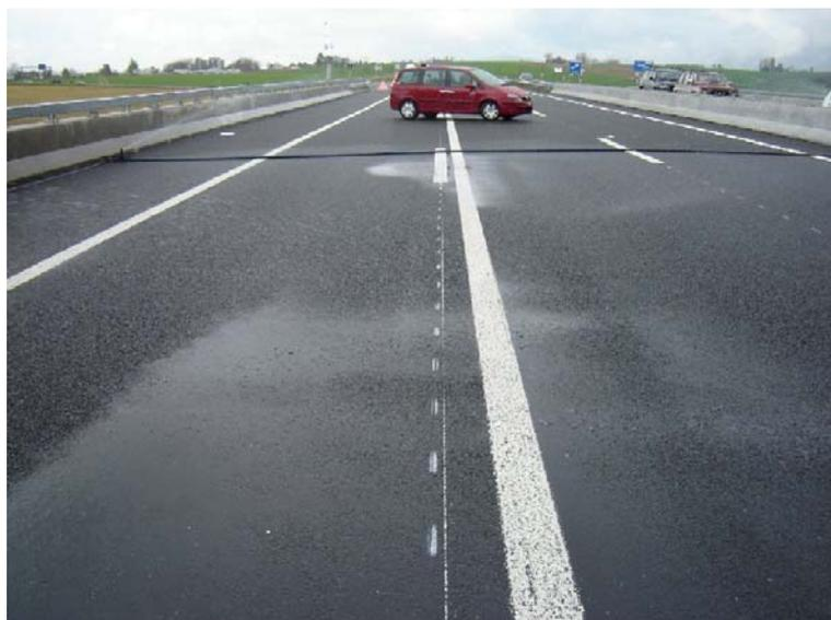
Figure 16: Zones saturées sur le pont.
