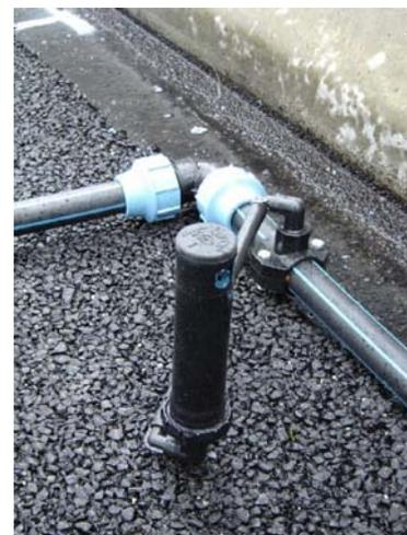
Figure 13: Système d'arrosage avec buses pivotantes sur 90°.
