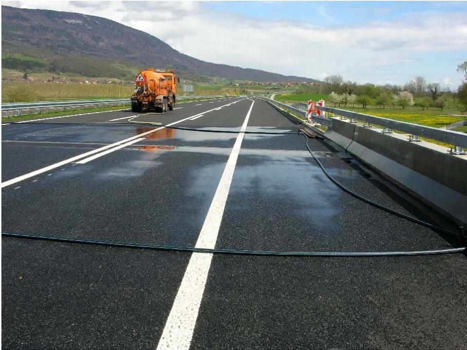
Figure 19: Zones peu saturées en amont du joint.
