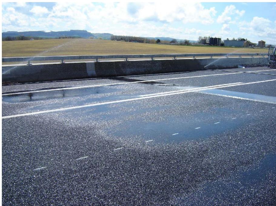
Figure 18: Zone fortement saturées en aval du joint.
