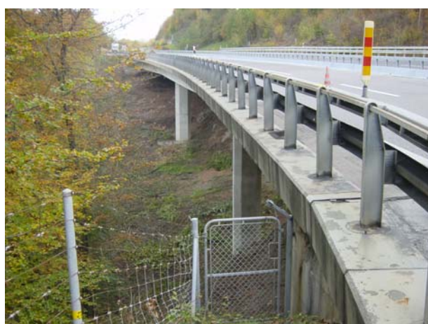
Figure 9-1: Pont sur la Denève
