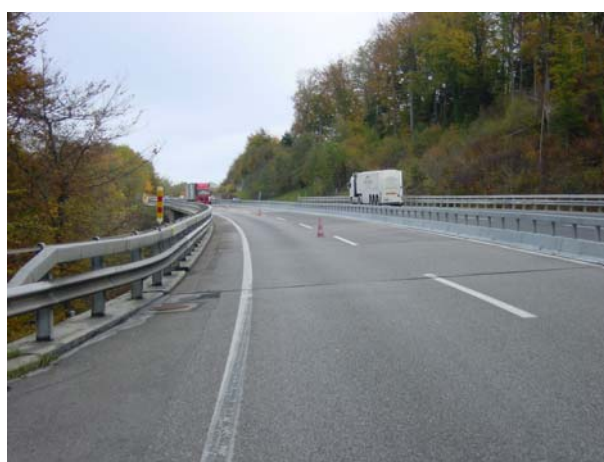
Figure 9-2: Pont sur la Denève
