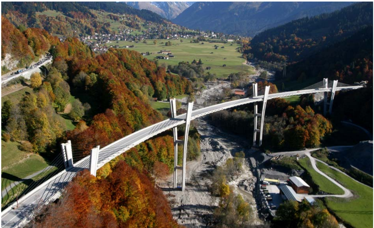
Bild 31 – Sunnibergbrücke, Umfahrung Klosters, Kanton Graubünden, 1998/2006. Integrale Länge 530 m. Foto: Tiefbauamt Graubünden.
