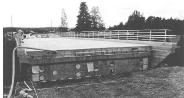
Bild 23 – Haavistonjoki-Strassenbrücke in Finnland [27]: Längsschnitt und Widerlagerwand mit Drucksensoren vor der Hinterfüllung.
