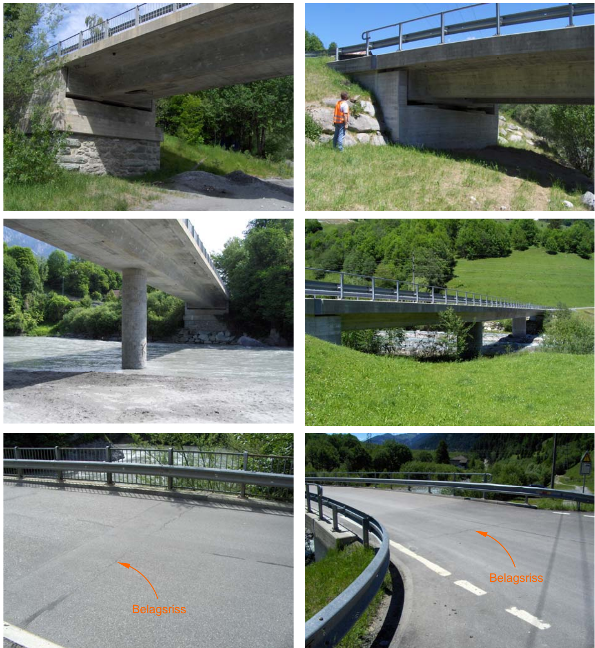
Bild 32 – Semi-integrale Brücken im Kanton Graubünden mit Widerlagerausbildung nach Bild 25 [69] (mit Lagern aber ohne Fahrbahnübergang). Links: Vorderrheinbrücke Reichenau, 1986, L = 68 m Rechts: Vorderrheinbrücke Cumpadials, 2000, L = 80 m.
