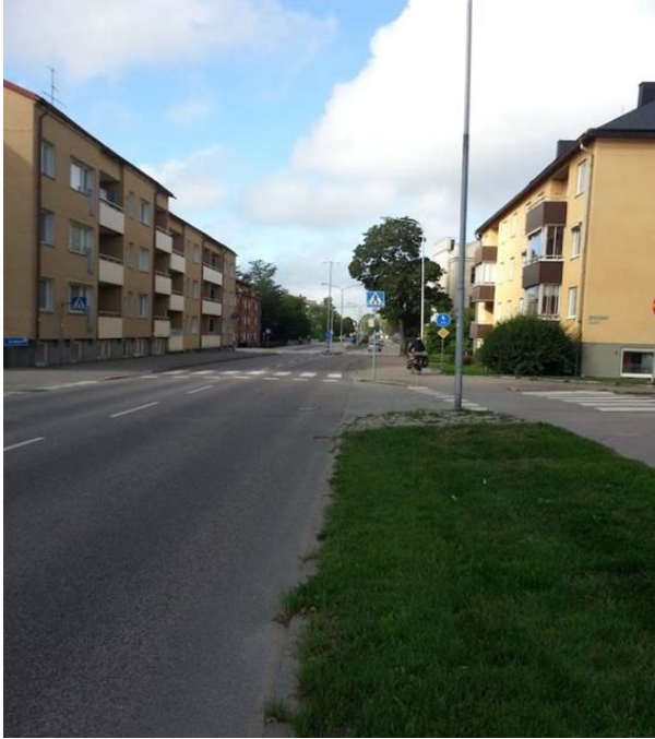
Figur 1. Gata med god hastighetsefterlevnad. Hastighetsbegränsning 40 km/tim, 75 procent kör inom hastighetsgränsen.
