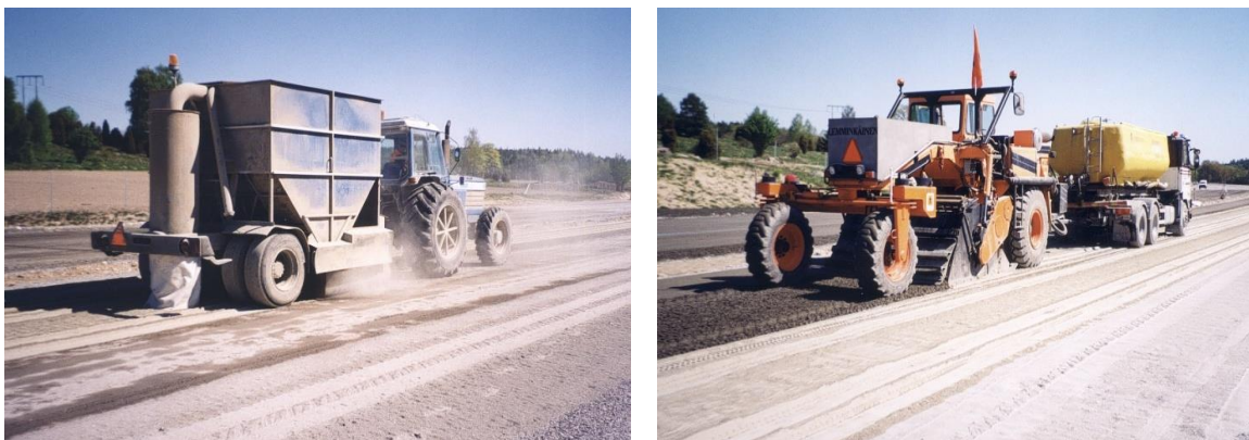
Figur 6. Vänster bild: Spridning av cement. Höger bild: Infräsning av cement i bärlager. (Foto: Stig Jansson).
