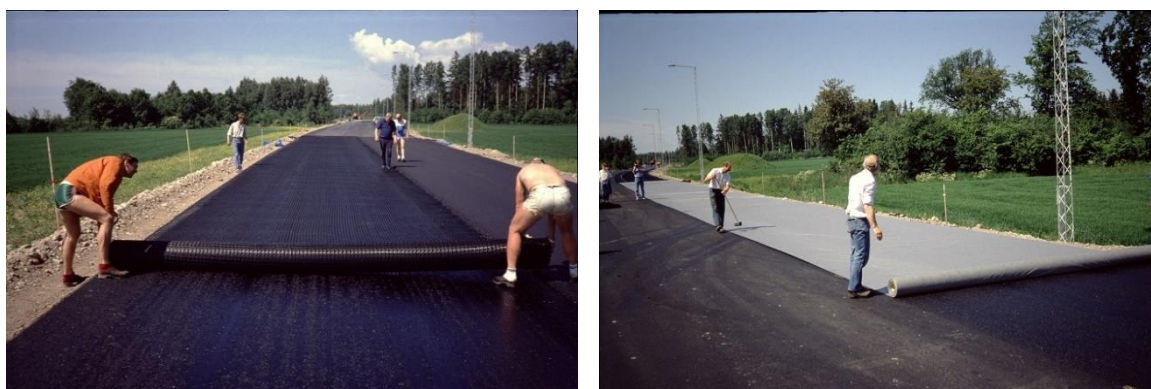
Figur 5. Vänster bild: Montering nät. Höger bild: Montering duk. (Foto: Bengt Åke Hultqvist).
