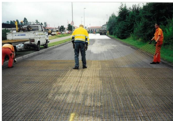
Figur 2. Vänster bild: Utläggning av glasfibernet. Höger bild: Utläggning av stål nät. (Foto: Bengt-Åke Hultqvist).
