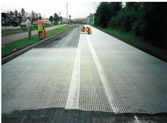
Figur 2. Vänster bild: Utläggning av glasfibernet. Höger bild: Utläggning av stål nät. (Foto: Bengt-Åke Hultqvist).
