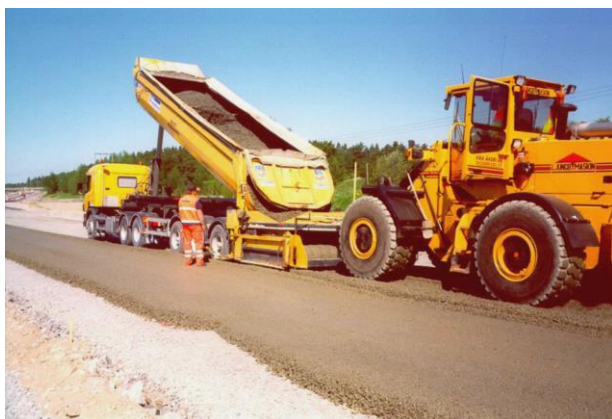
Figur 8. Exempel på utläggning av CG med bärlagerläggare MassMaster. (Foto: Stig Jansson).
