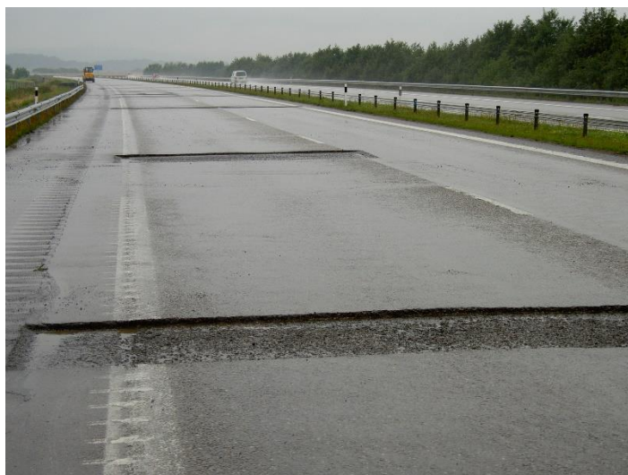
Figur 9. Fräslåda över de tvärgående sprickorna. (Foto: Bengt-Åke Hultqvist).
