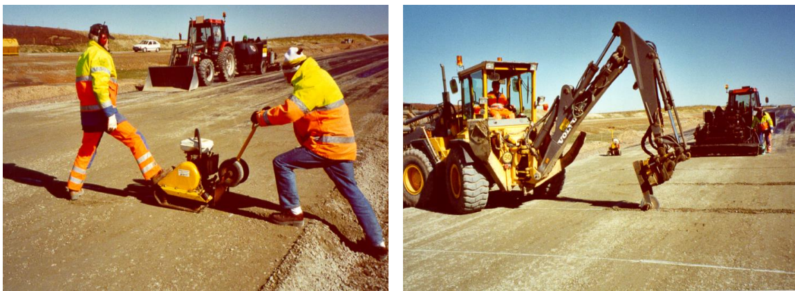
Figur 11. Vänster bild: Sprickanvisning med vibroplatta (hajfena under). Höger bild: Sprickanvisning med traktorgrävare. (Foto: Bengt-Åke Hultqvist).
