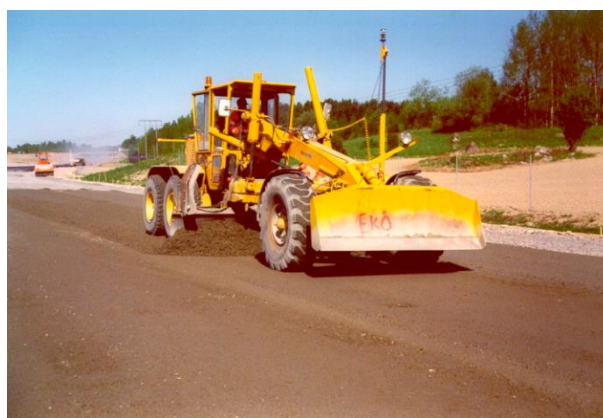
Figur 1. Vänster bild: Utläggning av CG med byggnadshyvel. (Foto: Bengt-Åke Hultqvist). Höger bild: Exempel på när CG-lagrets nivå justerades med byggnadshyvel. (Foto: Stig Jansson).
