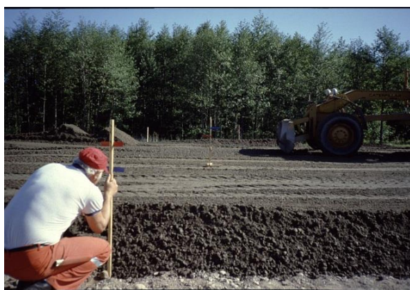
Figur 1. Vänster bild: Utläggning av CG med byggnadshyvel. (Foto: Bengt-Åke Hultqvist). Höger bild: Exempel på när CG-lagrets nivå justerades med byggnadshyvel. (Foto: Stig Jansson).
