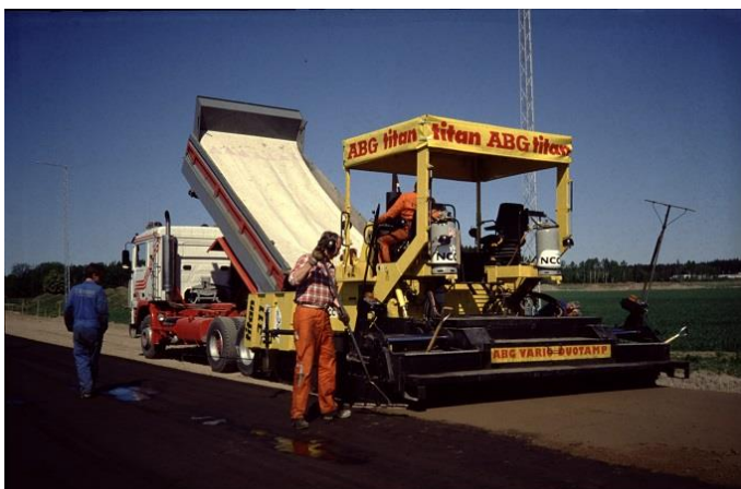
Figur 4. Utläggning av CG-bärlager. (Foto: Bengt-Åke Hultqvist).
