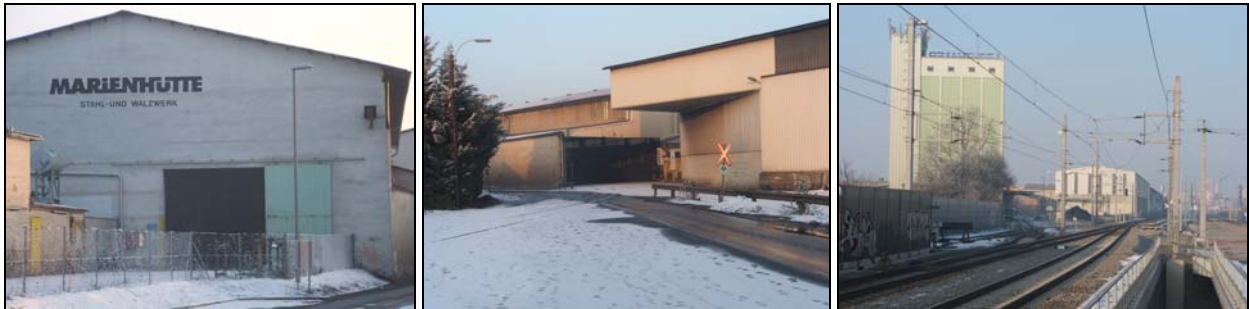
Abb. 4.2-59: Schleppbahn eines Stahl- und Walzwerkes an der Südbahnstraße (Agglomerat 211)
