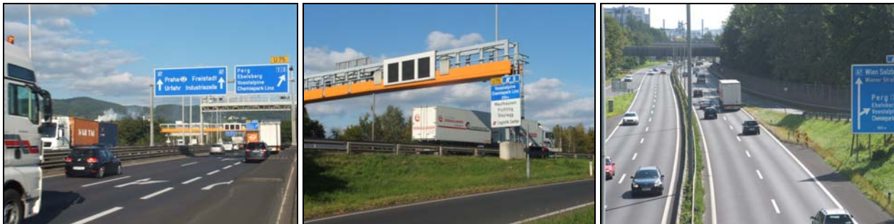
Brücke über Westbahn vor VÖEST
