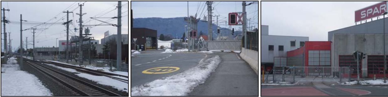
Abb. 4.2-61: Aufwändig hergestelltes Anschlussgleis für ein Lebensmittelzentrallager (Agg. 212)
