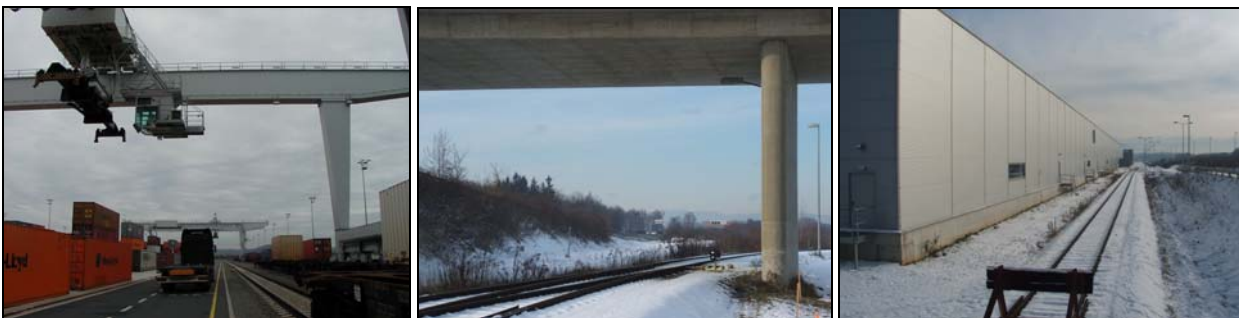
Abb. 4.2-63: Terminal Graz-Süd mit Containerumschlag (Agglomerat 222)
