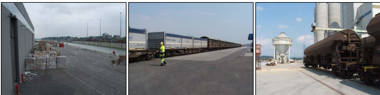
Abb. 4.2-54: Umschlagkais am Westbecken (Agg. 314) und am Ostmolo im Eco-Plus-Wirtschaftspark (Agglomerat 321)
