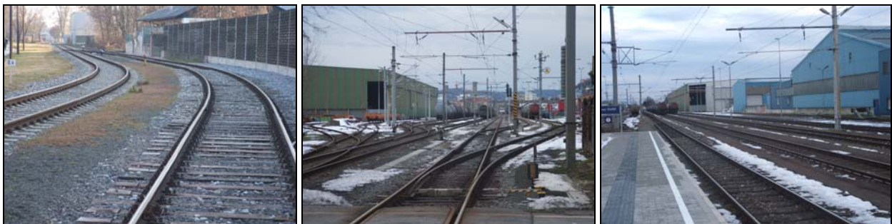
Abb. 4.2-67: Karlsruer Schleppbahn (Agg. 311) und Gütergleise in Graz-Ostbahnhof (Agg. 312)
