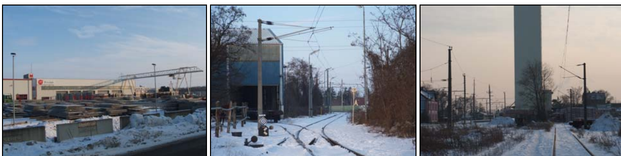
Abb. 4.2-26: Anschlussbahnen im Bahnhofsvorfeld von Gerasdorf (Agg. 322)
