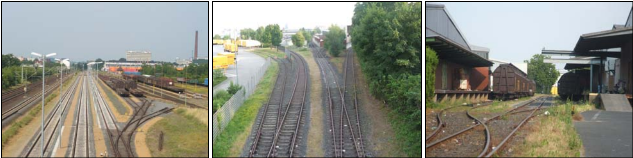
Abb. 5.1-4: Gleisanlagen der Frankfurter Hafenbahn
