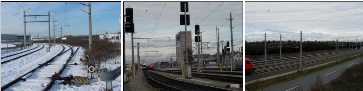
Abb. 4.2-62: Anschlussbahnanlage und Verschubknoten Kalsdorf und Übergabebahnhof K.-Süd (Agg. 221)
