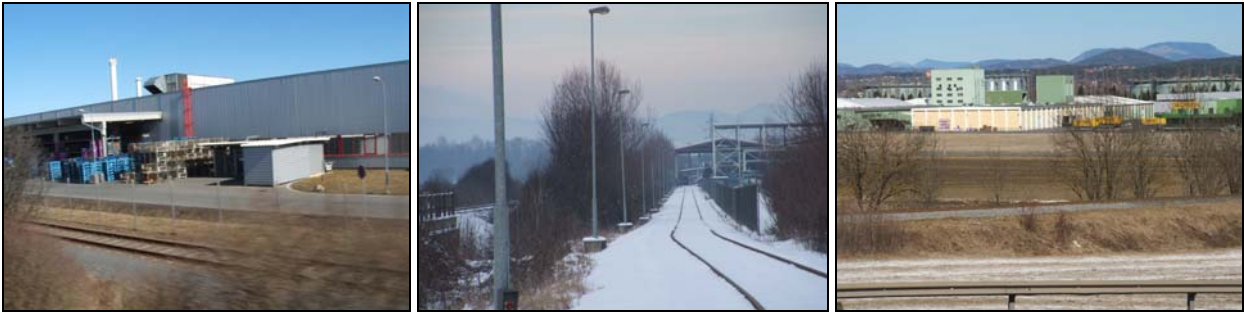
Abb. 4.2-64: Bediengleis zu den Anschlussgleisen in der Industriezone Lannach (Agglomerat 232)
