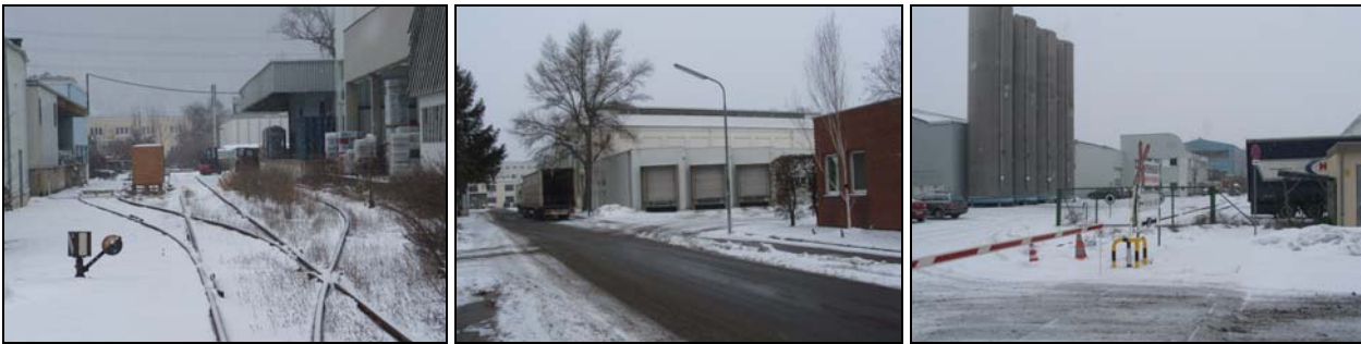
Abb. 4.2-21: Aufgegebene Anschlussbahnanlage Scheydgasse (Agg. 314)
