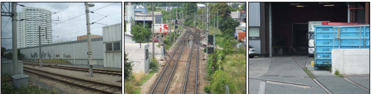
Abb. 4.2-29: Stillgelegte Anschlussbahnen an Vorortelinie (Agg. 412) und Verbindungsbahn (Agg. 411)
