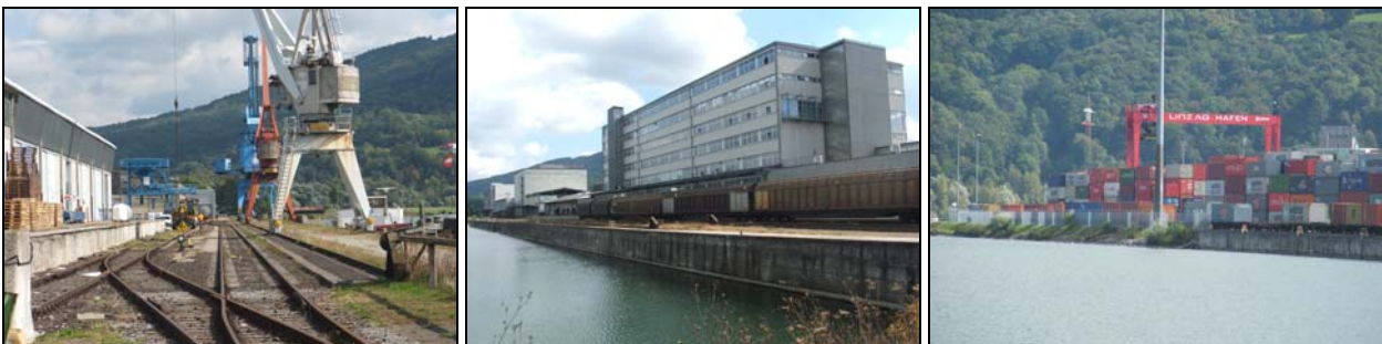
Abb. 4.2-45: Umschlagkais, Speichergebäude und Containerterminal des Stadthafens (Agg. 235 u. 234)
