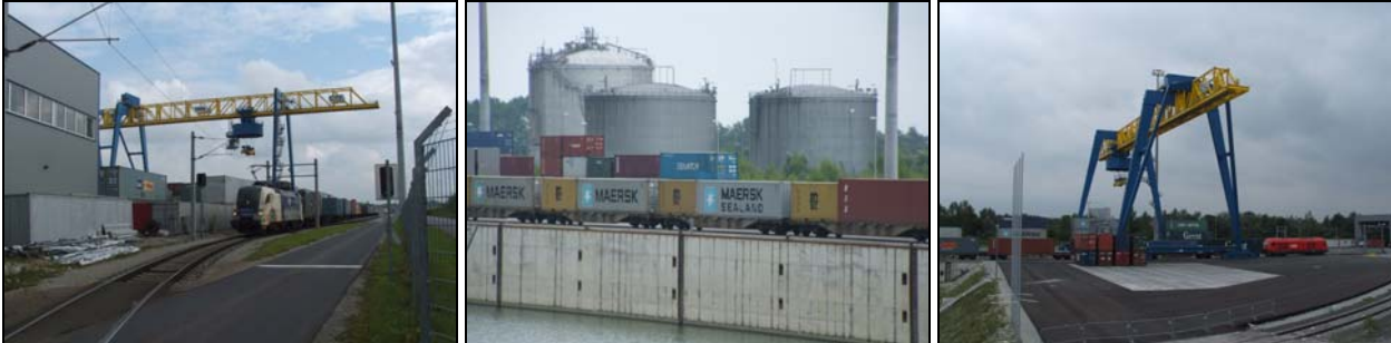
Abb. 4.2-53: Ennshafen-Containerterminal am Westbecken (Agglomerat 315)
