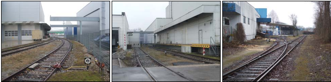
Abb. 4.2-39: Aufrechte, reduzierte und eingestellte Anschlussbahnen an der Rubensstraße (Agg. 153)
