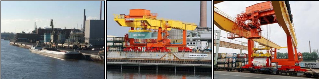
Abb. 5.1-8: Die Industrie-Länden und der trimodale Kombi-Terminal im Industriepark Höchst
