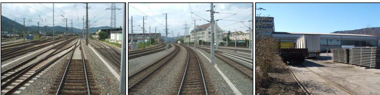
Abb. 4.2-58: Zulauf- und Bedienungssituation am Südkopf von Graz Verschiebebahnhof (Agg. 122 u. 123)
