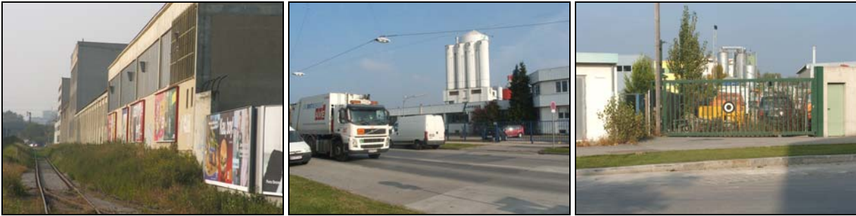
Abb. 4.2-14: Zurückweichende innerstädtische Anschlussbahnanlage Wildpretstraße (Agg. 141)
