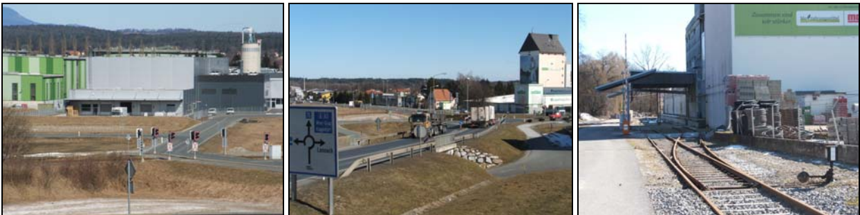
Abb. 4.2-65: Industriezone und Anschlussbahn zum Getreidesilo in Lannach (Agglomerat 232)
