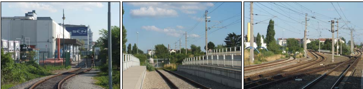
Abb. 4.2-22: Anschlussbahnen im Bahnhofsvorfeld von Jedlersdorf (Agg. 314)
