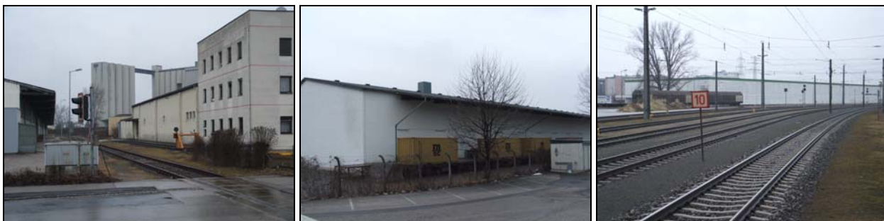
Abb. 4.2-38: Betriebszone östlich der Pyhrnbahn (Agg. 154)
